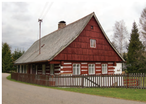
3. Chalupnický dům č. 3 se zachovaným trojdílným uspořádáním, roubenou světnicí a kolnou připojenou ve čtvrtém dílu dispozice je příkladem uplatnění tradic, formovaných již nejpozději od 18. století.
