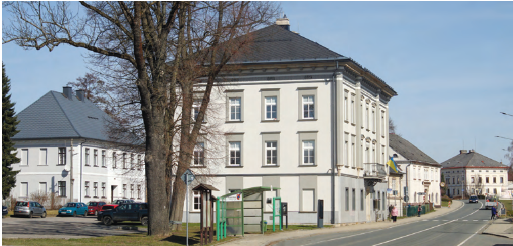
10. Centrum obce, kde se soustředily objekty městského typu ze závěru 19. století, je v poslední době snaživě opravené, ačkoli bohatá štuková výzdoba fasád se po období stagnace a neúdržby nepodařila zachránit. V popředí dům čp. 268, původně náležející významnému textilnímu podnikateli Ferdinandu Schmiedovi.
