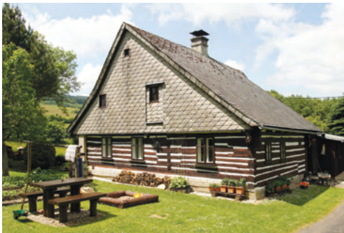
9. Hmota roubeného domu čp. 3 v Horních Boříkovicích prozrazuje tradiční jádro, k němuž patřila vysoká střecha prohnutého tvaru s mohutným komínem ve hřebeni a předsazený štít. Nynější asymetrie průčelí je vyvolaná úpravou krovu po rozšíření domu, již bez přetažení střechy pomocí námětků. K roku 1900 bylo v domě hlášeno 12 osob, převážně námezdních tkalců z větších továren v Červené Vodě a jejich děti.
