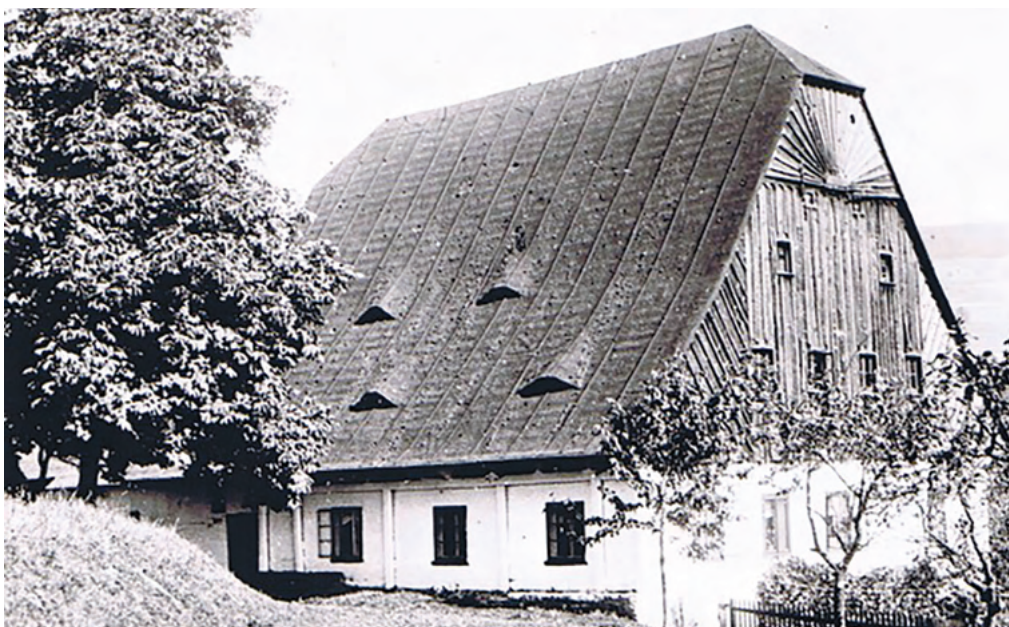
4. Unikátní nedatovaný snímek zachytil původní podobu dřevěné rychty, zaniklé při požáru v roce 1936. Významu stavby ve vsi odpovídala nejen situace v centru u kostela, ale také ojedinělé rozměry, zejména mohutná střecha a dekorativně skládané bednění štítu, s motivem slunce ve vrcholu. Stavba s čp. 11, zachycená k roku 1771, sloužila také jako hostinec. (kreis-landskron.de)
