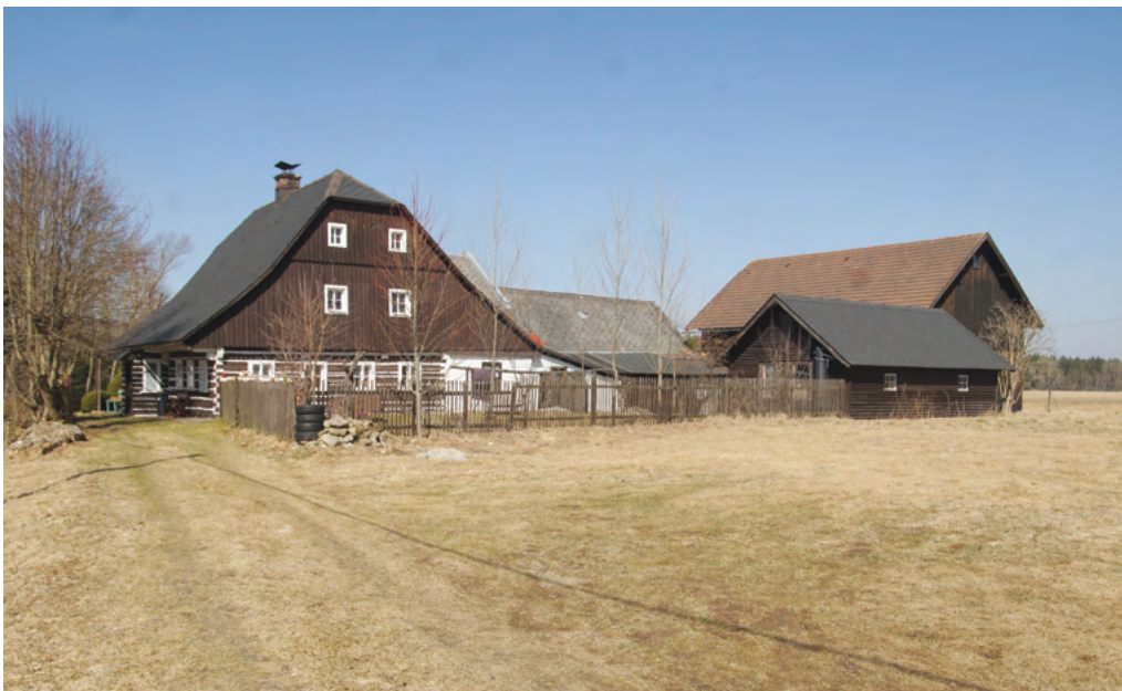
7. Větší selská usedlost čp. 61 s volným čtyřstranným dvorem a rozměrným obytným stavením tradičního typu, druhotně rozšířená o zděný zadní trakt. K roku 1945 zde Josef Seifert provozoval výrobu lněného oleje (Leinölmühle). (Registr ČV)
