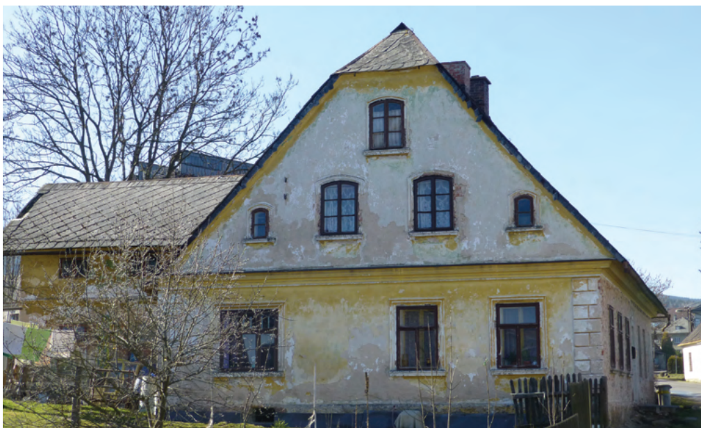
3-27 Červená Voda čp. 155. Přízemní dům zděný z cihel, postavený po polovině devatenáctého století, je příkladem typu s oboustranně obytnou dispozicí, což potvrzuje dvojice komínů, vystupujících ze hřebene střechy. Podkrovní místnost osvětluje trojice větších oken ve zděném průčelním štítu, naopak zadní dřevěný štít je krytý břidlicí.
