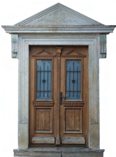
5-4 Portál domu čp. 2 ve Velké Moravě (původně čp.29) s vročením 1854 prozrazuje propojení obou inspiračních zdrojů – volutové římsy i tympanonu. Pod přebílením se zachovaly i stopy barevného zvýraznění zelených listenů na čele konzol.
