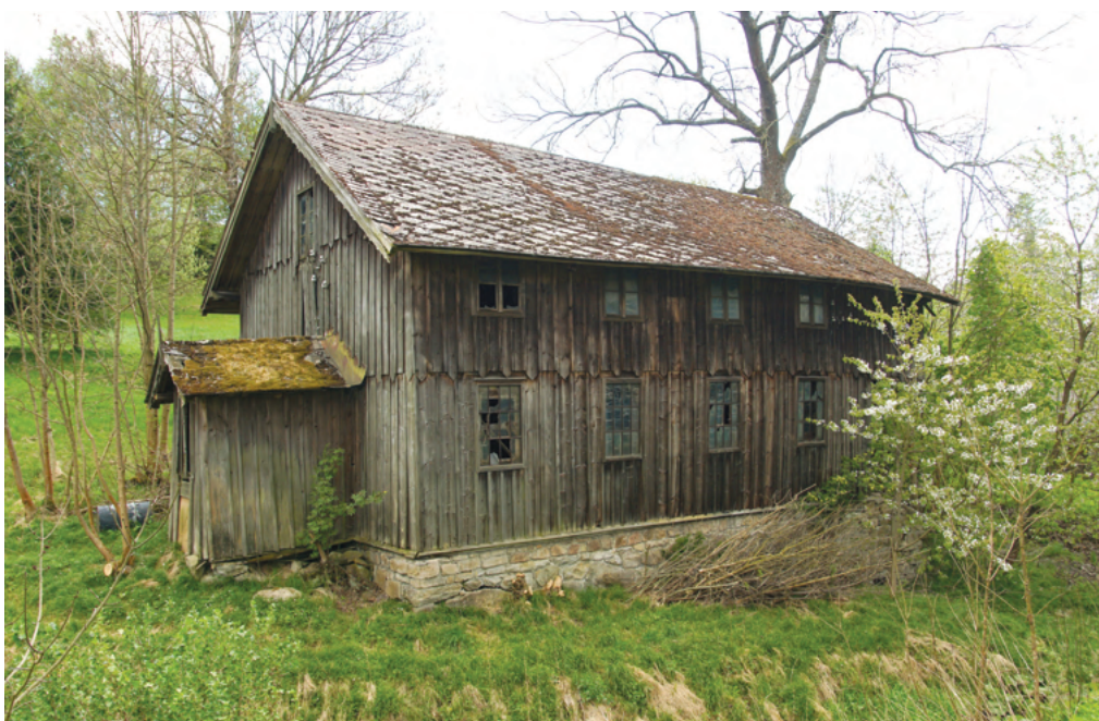
10. Olejna u čp. 60, výrobní objekt na vodní pohon z konce 19. století, se zachovaným technologickým vybavením. Bedněná stavba rámové konstrukce obsahuje olejnickou dílnu propojenou transmisemi a řemenicemi s vodním kolem v koncové lednici a v přístavku stoupu na drcení olejnatých semen. (Dokumentace průmyslového dědictví, NPÚ 2011)
