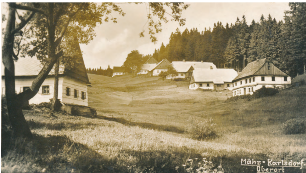
12. Zaniklý „horní konec“ vsi při cestě do Šanova, v současnosti pohlcený lesem. Nedatované historické foto zobrazuje na hraně údolí východně nad potokem řadu roubených obílených nebo omítaných chalup (existujících již před rokem 1839) s dřevěnými nebo šindelem pobítymi štíty a poměrně malými okny. (Archiv obce Červená Voda)
