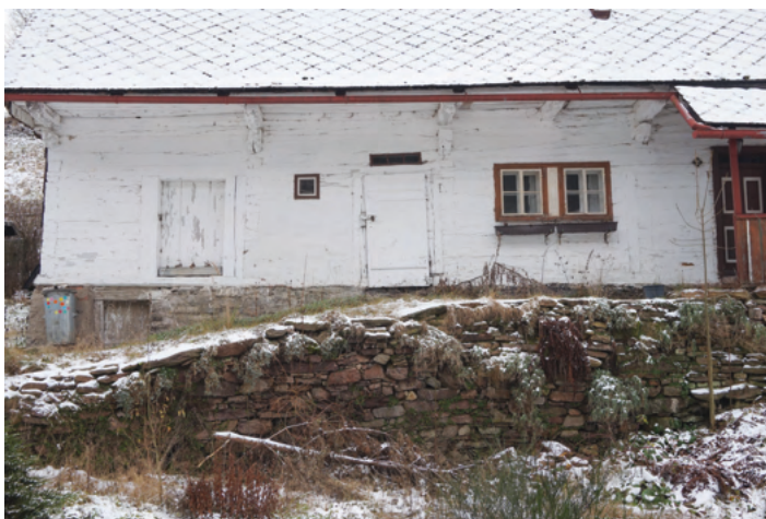
3-5 Orličky čp. 97, jednotný dům v tradiční roubené podobě. Pohled na podélnou stěnu představuje názorný příklad návaznosti jednotlivých dispozičních dílů v jedné řadě za sebou, pod společnou střechou, se vstupy ze zápraží, chráněného přesahem střechy. Svažité terén bývá využitý k zapuštění kamenného sklípku, zde se vstupem zvenčí. K zápraží vede taras z kamenné rovnaniny. K typickým znakům patří široké a nízké vstupy s trámkovými zárubněmi a svlakovými dvířky a pro Orličky typické mladší provedení osvětlení komory v podobě sdrúženého okénka.
