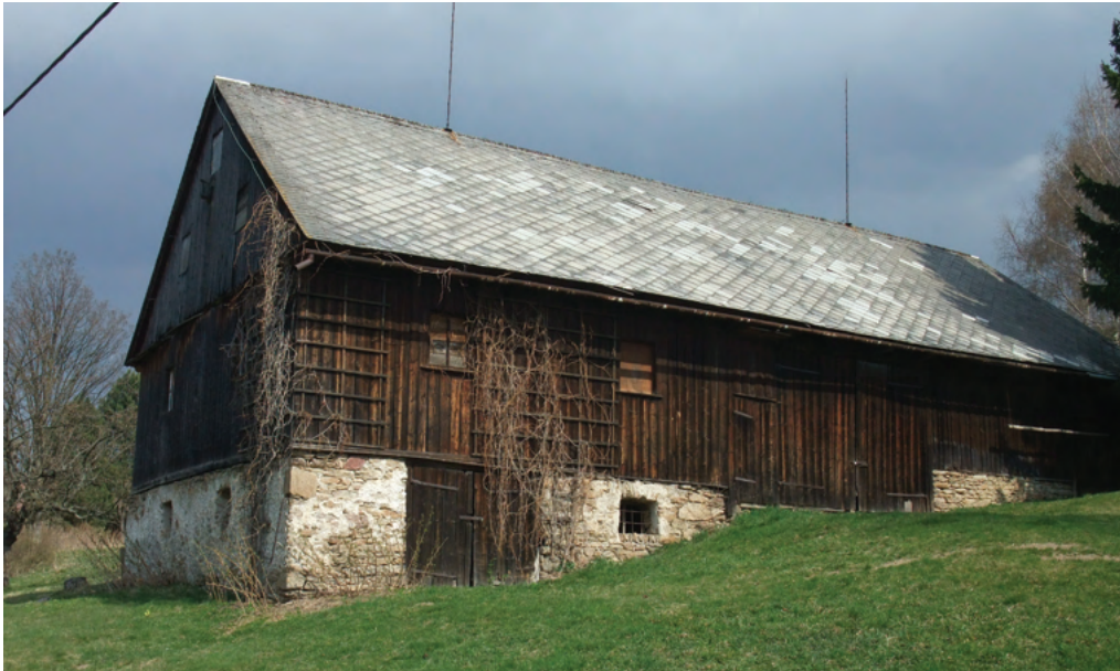
3-42 Velká Morava čp. 25. Stodola rámové konstrukce s prkenným obložním, využívající svažitost terénu k částečnému patrovému uspořádání, byla provedena jako novostavba po roce 1870.
