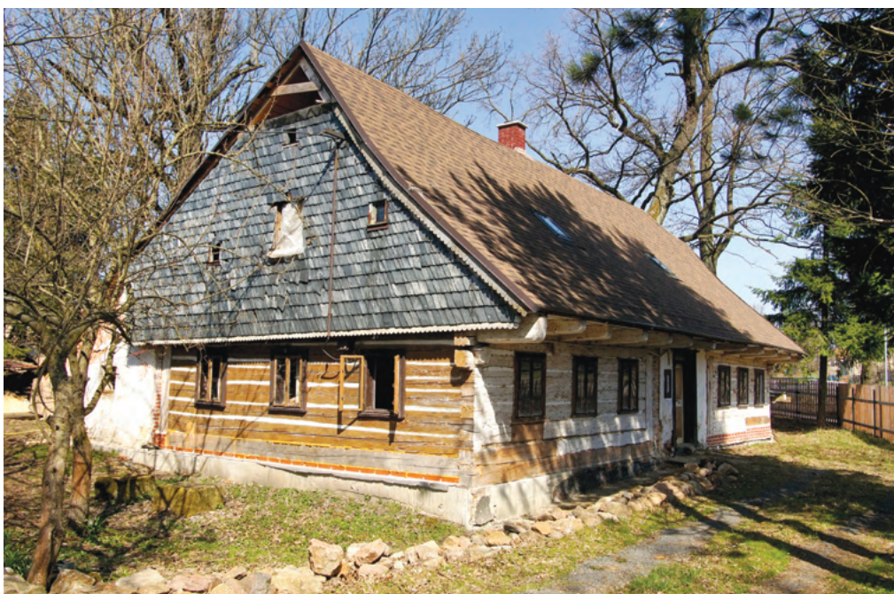
5. Domy čp. 74, 357 a 279 nesou dosud znaky tradičních venkovských staveb východosudetského typu, zejména prostorné a vysoké střechy, lehce přesazené bedněné nebo šindelové štíty později pokrývané břidlicí a výrazný komín s kamennou hlavicí nad síní uprostřed dispozice.
