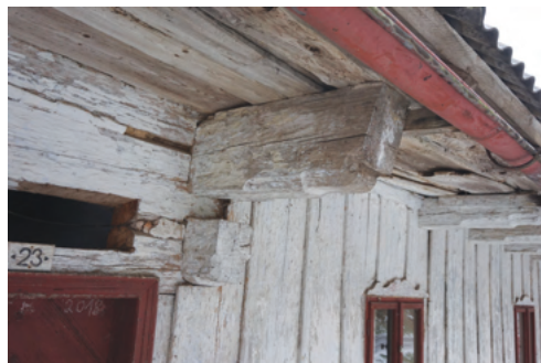
3-4 Orličky čp. 23, pohled na fortelně tesané zakončení stropních trámů a prkenný obílený obklad stěny světnice, který představuje jeden z tradičních způsobů zateplení a ochrany roubených stěn před nepřízní počasí. Nad okny světnice se zachovala redukovaná podoba vyřezávaných dekorativních šambrány.
