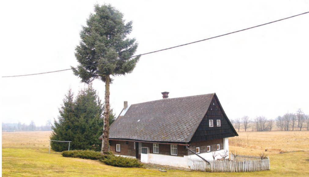
8. Domek čp. 29 byl postaven mezi lety 1787 a 1840 jako výměnek mateřské usedlosti čp. 6, na jejichž pozemcích stojí. V roce 1890 jej obýval nájemní tkadlec, původem z Bystrce. Výměna některých oken a překrytí roubení částečně setřely jeho autenticitu, přesto si objekt dosud uchovává tradiční hmotu a formu a podle vnějších znaků i dispoziční členění. (SL)
