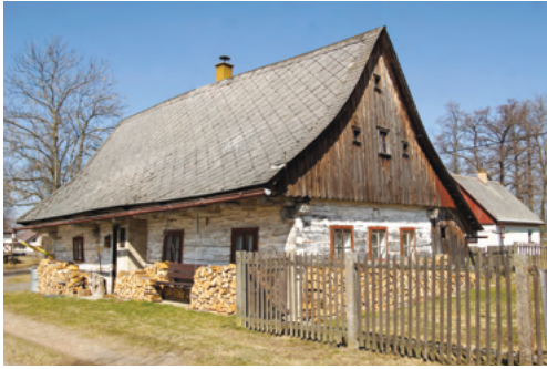
5. Drobný roubený dům čp. 68, uváděný k roku 1787 jako výměnek k čp. 69, který patřil rodině Höppe ještě v roce 1869. Objekt s jednoduchou trojdielnou oboustranně obytnou dispozicí zachovává řadu tradičních znaků, jako rybinové spoje roubení, tesařské zdobení přesahujících horních trámů, tvar a symetrické nasazení střechy, i malá okna téměř čtvercového formátu. (Registr ČV)
