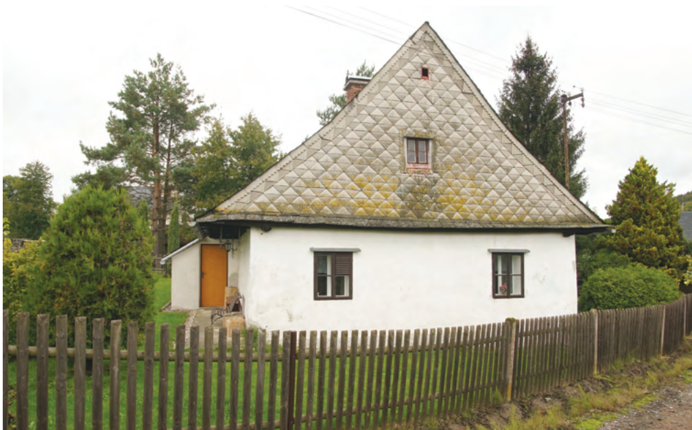
6. Předchůdce domu čp. 35 byl zachycen v roce 1771 prvním okruhem číslování, před rokem 1798 se uvádí koupě domu od vrchnosti. Zděný dům byl postaven v roce 1832 stále s tradičním tvarem střechy s dlouhými námětky a přesahem po obou stranách. (Registr ČV)
