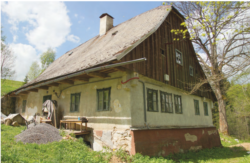
7. Omítnutý roubený dům sedláka čp. 21, postavený na okraji lánu nad strží s potokem. Charakteristická je trojdílná dispozice a široké průčelí s více okny (velké světnice jsou časté v oblastech s domácí tkalcovskou výrobou na stavech), vysoká střecha s lehce přesazeným bedněným štítem a valbičkou ve vrcholu. Za první republiky zde krátce působila česká menšinová škola. (SOKA Šumperk)
