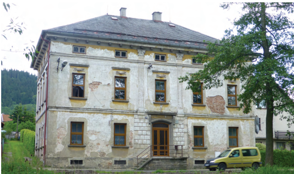
3-35 Červená Voda čp. 249. Patrový dům spojující reprezentativní funkci bydlení s obchodní činností je proveden s historizující fasádou z poslední třetiny 19. století. Objekt představuje ukázkou stavební produkce ambiciózního období průmyslové revoluce a fáze přestavby vesnice v sídlo městského charakteru.
