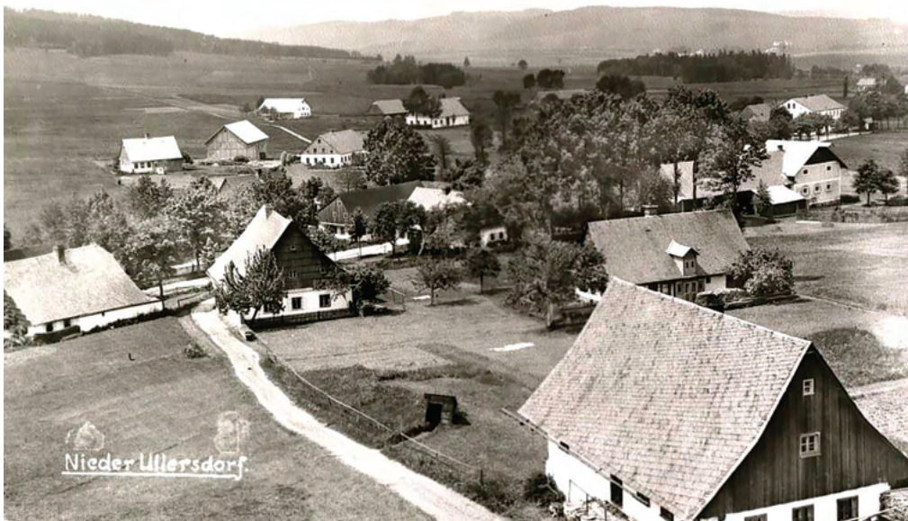
3. Pohled na část Dolních Bořkovic z meziválečného období 20. století, zahrnující průřez typovou skladbou zástavby od roubených domů s vysokou prohnutou střechou, přes zděné domy s nízkými trojúhelními štíty po stavby z přelomu 19. a 20. století, zastoupené zděnou hospodářskou stavbou s polopatrem a seníkovou kladkou, nebo vysokou bedněnou rámovou stodolou. (MM Králíky)
