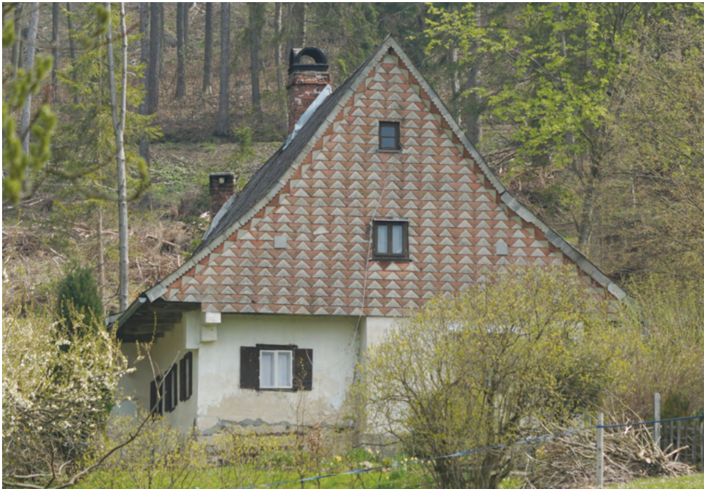
5. Roubený domek čp. 84 kdysi zahradnické usedlosti s hákovým půdorysem, vklíněné mezi statky čp. 26 a 27, zamenaný až k roku 1839, si zachoval navzdory částečnému přezdění tradiční hmotu a konstrukci střechy. K roku 1880 zde žila rodina Knöleů, kteří se živili tkalcovstvím a výrobou bavlněného zboží. Dekorativní eternitová úprava štítu reprezentuje zřejmě ještě meziválečné období. (SL)
