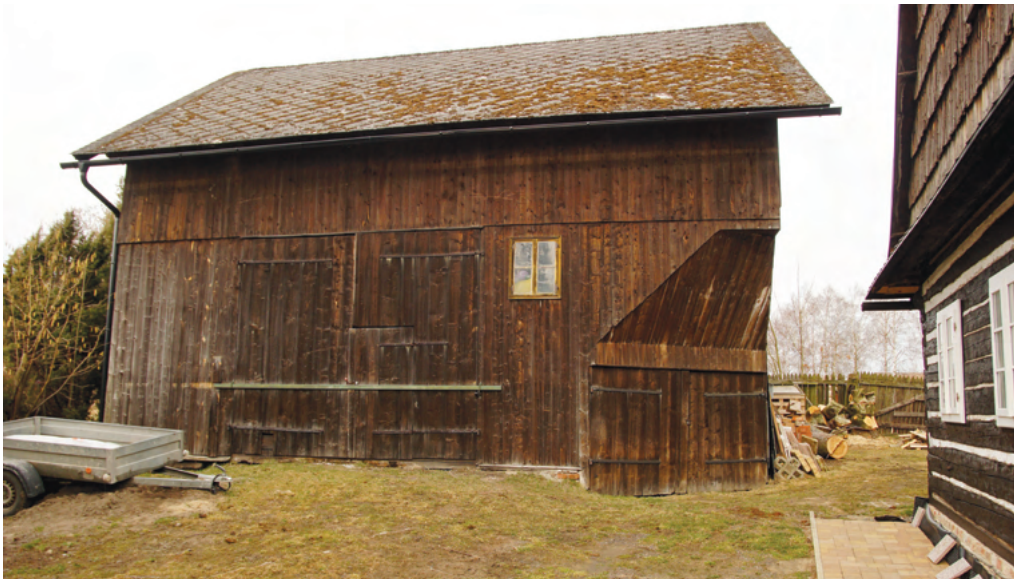
12. Atypické provedení převýšené dřevěné kolny rámové konstrukce z přelomu 19. a 20. století, ve dvoře domu čp. 138, vyvolala potřeba průjezdu do zahrady na stísněném pozemku domkářského stavení. V roubené chalupě žilo k roku 1880 ve dvou bytových domácnostech celkem 8 členů rodiny Kuttigů, žijících se jako námezdní tkalci.
