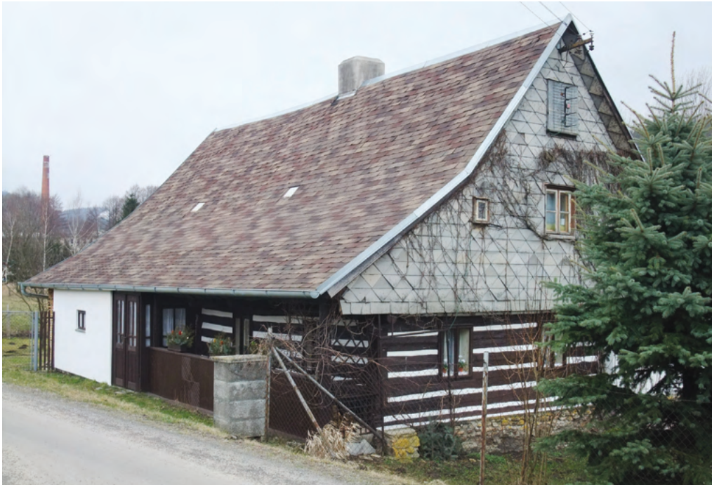
4. Dům č. 1 smíšené konstrukce s roubenou světnicí a dřevěným štítem je příkladem tradičního objektu ještě ze závěru 18. století. Před rokem 1798 dům patřil ševci Brixovi, od roku 1824 domkáři Häuslerovi, který je k roku 1869 uváděn již jako přadlák a obchodník. Domek s ním obývali i tkadlec a zámečnický tovaryš. (Registr ČV)
