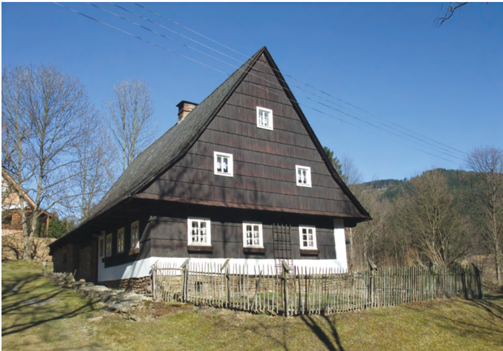
5. Chalupa čp. 25 na okraji bočního údolí byla již před rokem 1839 součástí menší dřevěné párové usedlosti. Zemědělství je v rodině majitele doloženo ještě k roku 1900. Z mladší stodoly se zachovaly jen fragmenty kamenného zdiva. Obložení dřevěného štítu i roubení vrstvami šindele je v horském prostředí běžným způsobem ochrany konstrukce. (SL)
