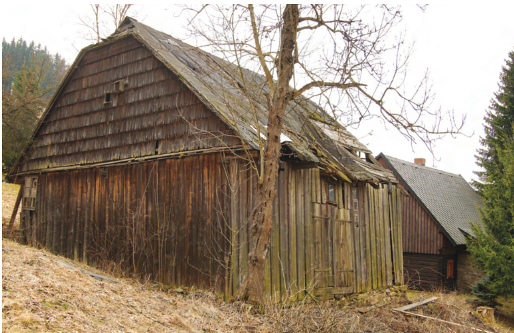
10. Příklad menší izolované dřevěné stodoly rámové konstrukce s tradiční valbičkou nad štítem pobitým šindelem.
