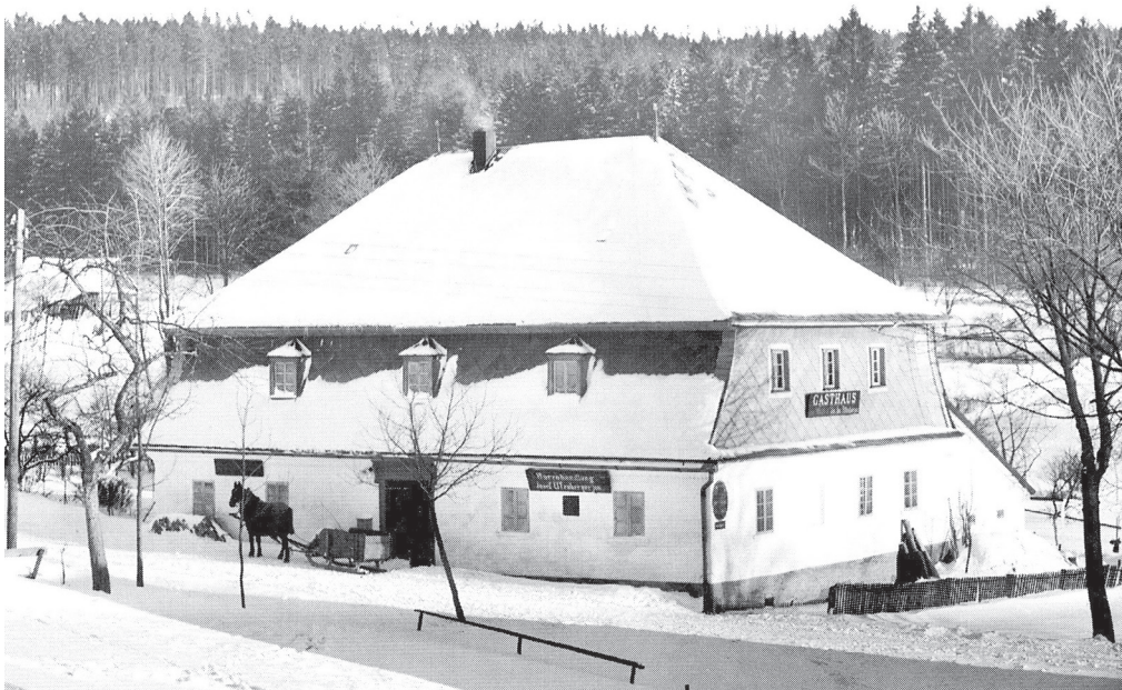
9. Dům čp. 16, již od roku 1802 v majetku významné podnikatelské rodiny Effenbergerů, získal svoji výstavnou klasicistní podobu s obchodem zřejmě až v polovině 19. století. Jeho význam připomíná v nyní opuštěném a devastovaném objektu již jen konzolové nadpraží bývalého vstupního portálu s vrocením 1859 a jménem stavebníka. (OÚ Červená Voda)
