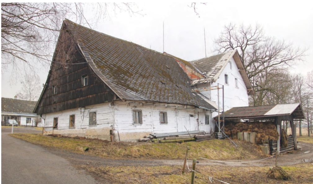
4. Autentickým pozůstatkem selské usedlosti čp. 22, která byla od počátku součástí historické sídelní struktury vesnice, je dosud stojící přední část jejího domu. Ta je zástupcem nejstarší dochované vrstvy jednotných roubených venkovských domů Králicka. Jména selských majitelů Greissler z roku 1839 nebo Hufnagel z roku 1890, upomínají na tehdejší německojazyčnou komunitu. Zadní roubený díl domu nahradilo mladší kolmé zděné hospodářské křídlo se seníkovým polopatrem, asi z 20. let 20. století. (SL)
