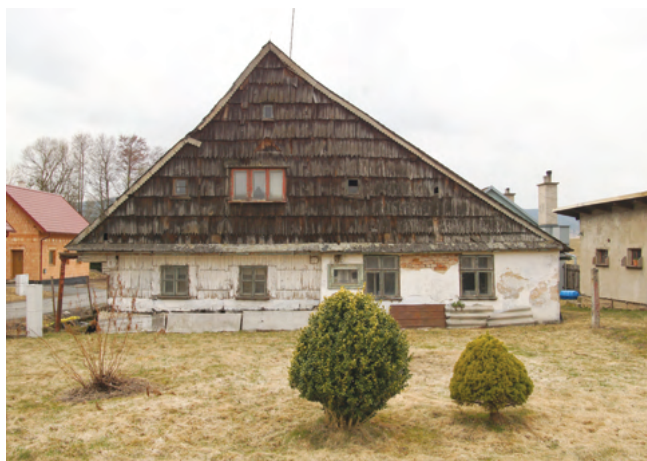
6. Dům čp. 85 je zástupcem nejstarší dochované vrstvy tradičních jednotných roubených domů ve vsi, číslo bylo přiděleno roku 1771. Asymetrická silueta vznikla postupným rozšířením. K typickým znakům patří bedněné štíty, obkládané později šindelem nebo eternitem. V detailu štítu je vidět trojúhelníková jizva po odstranění kukličky nad kdysi menším osově umístěným oknem. Dům postavený na bývalém rychtářském gruntu později sloužil jako obchod s přízí a domácká kartáčníká výroba. (Registr ČV)
