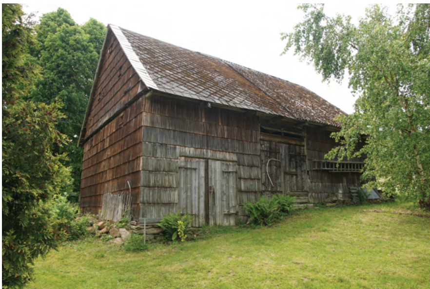
13. Příkladem samostatné dřevěné hospodářské stavby je stodola rolnické usedlosti čp. 58, původně kratší, opatřená někdy po roce 1850 střechou nižšího sklonu. Pod šindelovým opláštěním nelze zvenčí rozeznat, zda jde o rámovou konstrukci, nelze vyloučit ani částečné roubené provedení.
