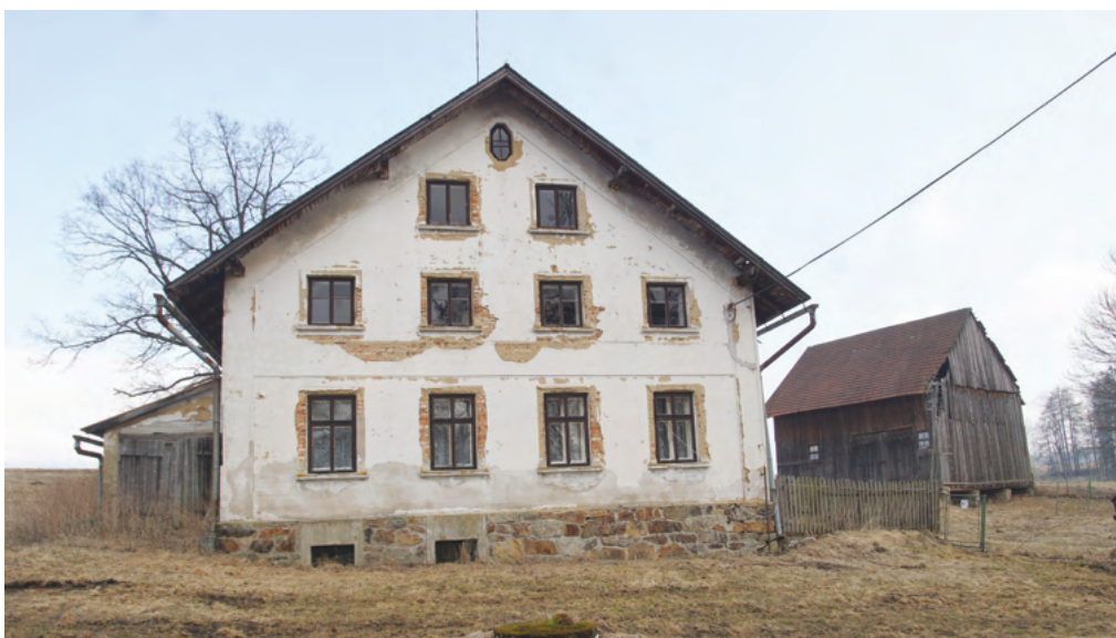
10. Dům čp. 47 byl zřízený jako novostavba ve dvacátých letech 20. století náhradou za starší dřevěný obytný objekt. Dřevěná stodola má pravděpodobně starší jádro, druhotně upravované nejspíš současně se změnou krovu.
