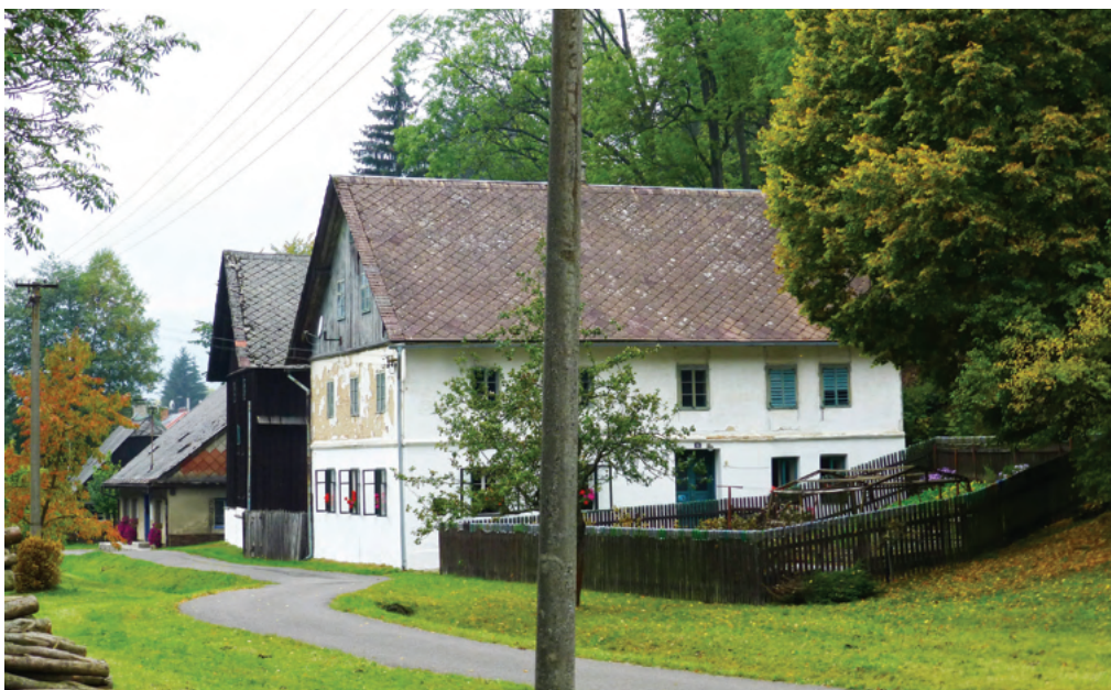
10. Selská usedlost čp. 63, ve štítové orientaci s paralelní bedněnou stodolou, se zachovala v úpravě odpovídající závěru 19. století. V zadní části obytného patra se konstrukčně uplatňuje lehké hrázdění, ve zdejší oblasti obvykle neužívané.
