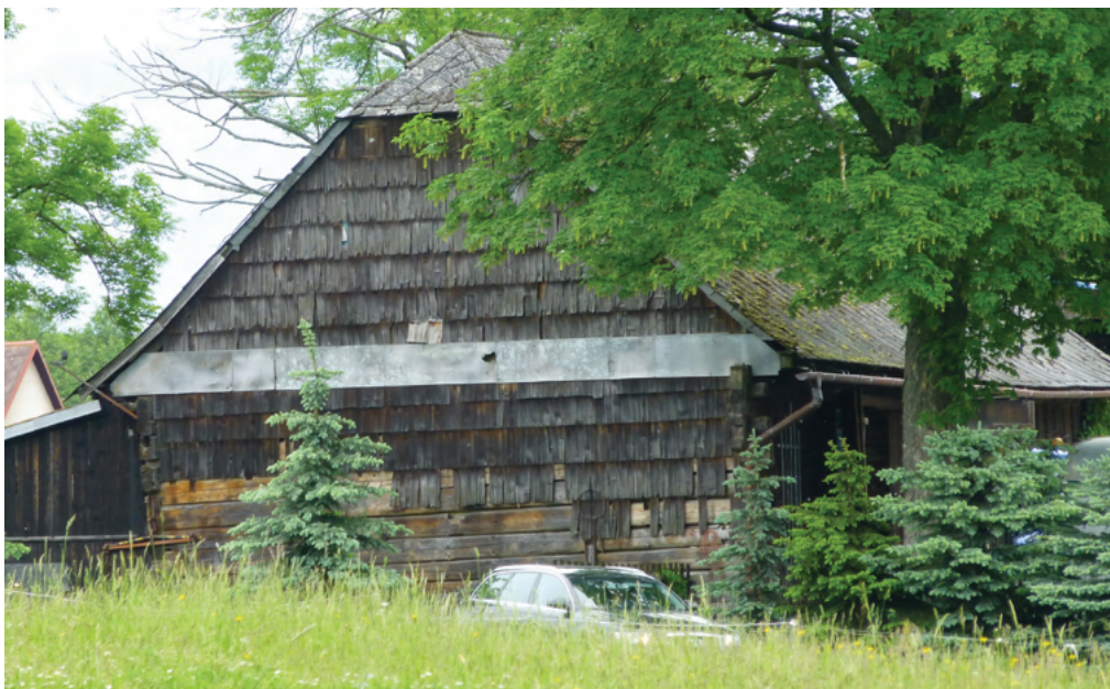
7. Roubená obdélná stodola u čp. 2 byla postavena již před rokem 1816. Pokrytí stěn šindelem pochází zřejmě z mladšího období.
