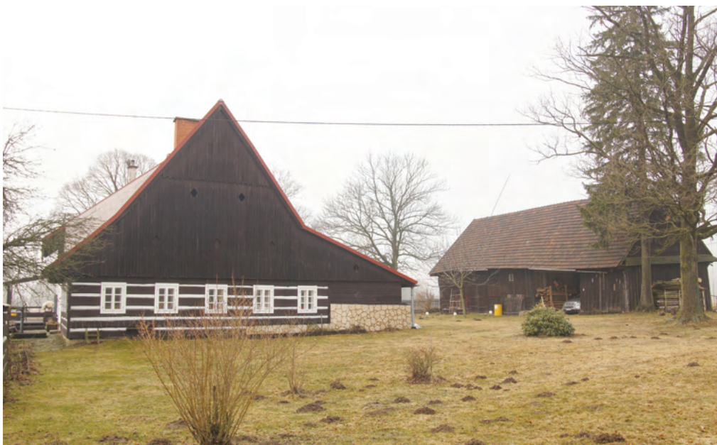
5. Popisné číslo 20, udělené roku 1771, náleží jedné z usedlostí zachovávajících kontinuitu nejstarší sídelní struktury. Nespalný dům a dřevěná stodola, potvrzené v nynější paralelní pozici již před rokem 1840, tvoří jádro dnes již modernizovaných staveb. Dlouhá stodola se dvěma mlaty, v dolní části s roubenými, třebaže druhotně sestavenými stěnami, je ojedinělým dokladem, potvrzujícím výskyt roubených konstrukcí i u starších hospodářských staveb na Králicku. Adaptace na rozměrnější stavbu rámové konstrukce s nižší střechou pochází patrně až z doby po polovině 19. století.
