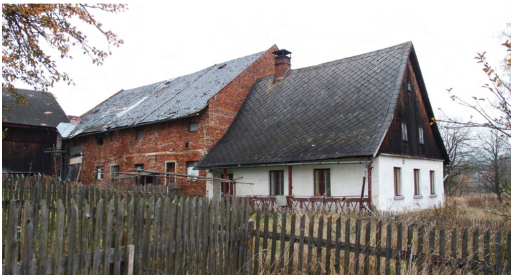
3-37 Horní Lipka čp. 65, selská usedlost dokumentující postupný růst a modernizaci zadního hospodářského dílu domu v závěru 19. století, při zachování starší obytné části domu, s tradičním prohnutým tvarem střechy.
