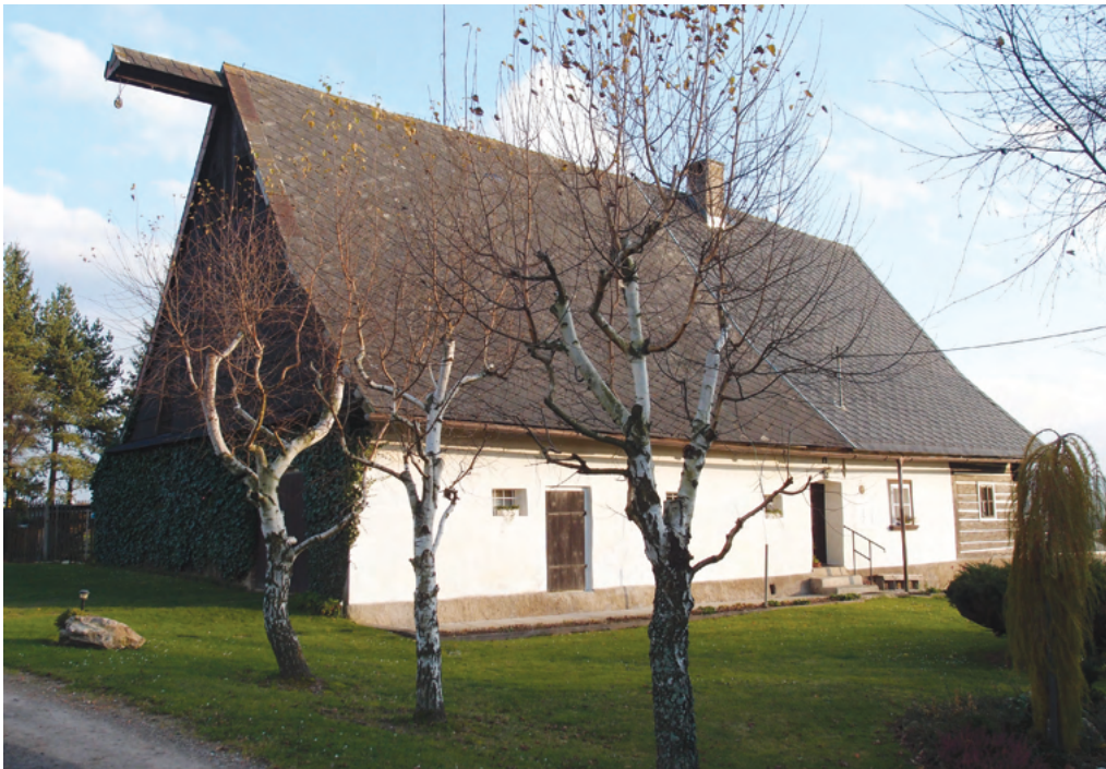
4. Dům čp. 33 je pozůstatkem usedlosti, jejíž menší dřevěná stodola již zanikla. Tradiční vysoký a prohnutý tvar střechy nad roubenou světnicí s drobnými čtvercovými okny, funkční členění dispozice s komínem ve hřebeni nad síní a dříve šindelem krytý štít patří ke znakům indikujícím nejstarší vrstvu zachovaných venkovských staveb v okolí. Naopak modernizaci hospodářského provozu z přelomu 19. a 20. století, umožňující snadnější ukládání sena do podkrovní, dokládá vysunutá kladka ve štítu. Kromě vdovy a výměnkářky zde k roku 1880 žil také kněz na odpočinku. (SL)
