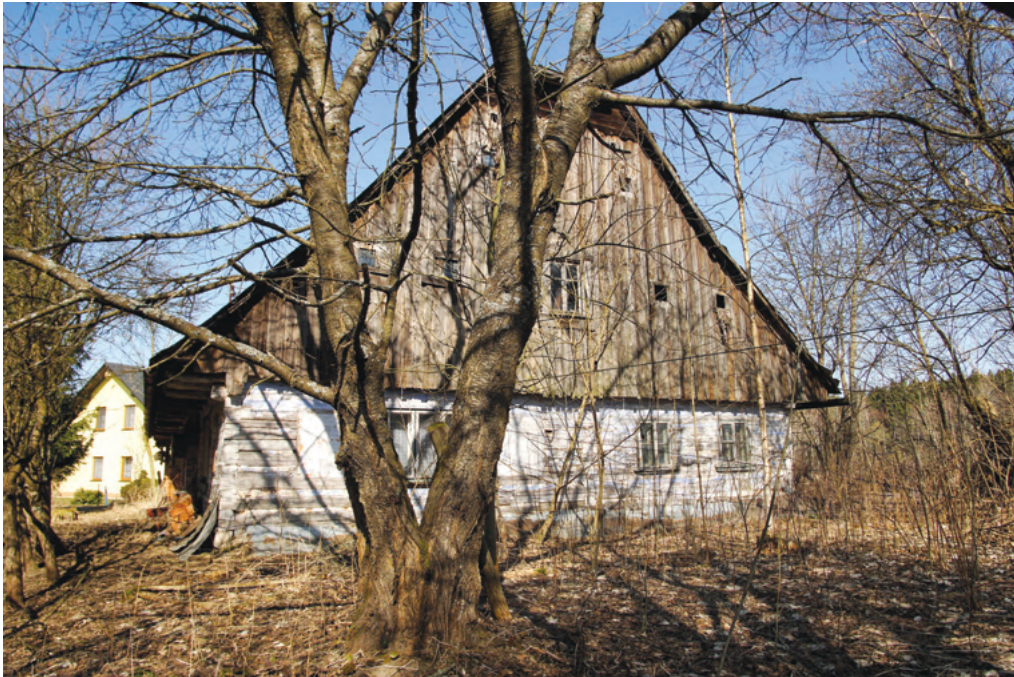
6. Opuštěný dům selské usedlosti čp. 57, s atypicky širokou roubenou obytnou částí a mohutnou střechou zakončenou předsazeným visle bedněným štítem, navazuje v ose na nižší roubenou kolnu. Oproti jiným stavbám se zde uplatnilo i obarvení vápna přidavkem šmolky. Popisné číslo bylo zachycené k roku 1771, usedlost byla od roku 1857 ve vlastnictví rodu Seifertů. (Registr ČV)
