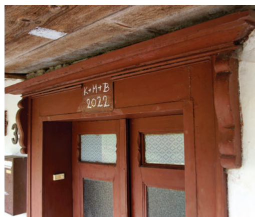
5. Dům čp. 35 tradičního objemu s prostorným podkrovím o více úrovních pod vysokou střešou. Originální roubení již nahradilo mladší cihelné zdivo, dispozice s komínem nad průchozí síní se zachovala. U vstupu je uplatněný oblíbený typ portálu s římsou na volutových konzolách, zde ojediněle v dřevěném provedení. K domu patří i dřevěná, šindelem pobitá kolna.
