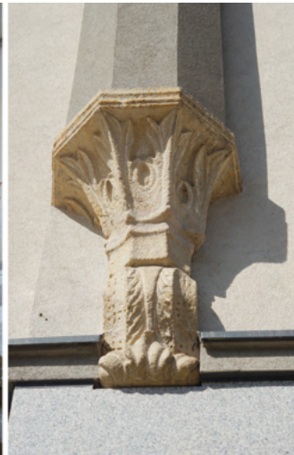
11. Příklady užití dekorativních reliéfních prvků na fasádách z období historismu, často připravovaných jako dílenský prefabrikát a montovaných dodatečně na stavbu. Reprezentativní úprava zahrnovala i interiérové haly se sloupy a mřížovým zábradlím nebo náročně vyřezávané dveře.
