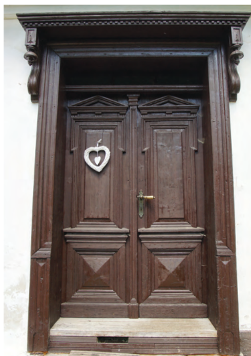
5-12 Unikátní transformace portálu do dřevěného provedení se zachovala na domě čp. 52 v Moravském Karlově, opět v jednotném historizujícím provedení s dvoukřídlými dveřmi s neorenesančními výplněmi. Truhlářské provedení konzol přebírá prvky stylového nábytku např. v provedení soustružených čučků, připomínajících zavěšené lucerny.
