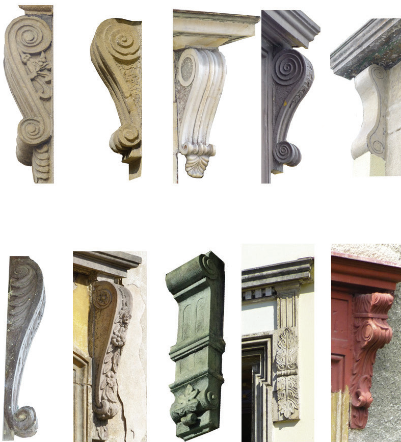
5-10 Tvarová variabilita konzol naznačuje vývoj od klasických proporcí volut, přes protáhlé a štíhlé volutové konzoly s reliéfní rostlinnou dekorací (pravděpodobně barevně pojednanou) až k manýristickým tvarovým hříčkám, které k původním volutám odkazují jen velmi vzdáleně.
