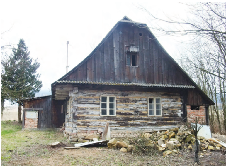
3. Roubený domek (dříve čp. 21) byl postaven jako výměnek usedlosti čp. 14 v tradiční podobě, odpovídající období na přelomu 18. a 19. století. Zadní díl byl zděný z kamene, jeho štít měl konstrukci pro pobití šindelem. Usedlost i domek nedaleko nynějšího čp. 17 v nedávné době zanikly. (Foto 2016)
