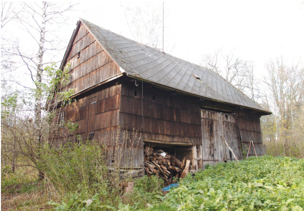
8. Starší malé domkářské stavení čp. 153 bez pozemkové držby, postavené v přímém sousedství dominikálního dvora, získalo svoji zděnou podobu před rokem 1839. Svým provedením odpovídá jednoduchým, klasicismem ovlivněným stavbám na Králicku. K roku 1880 uvádí sčítací operát majitele olejny. K domu byla po rozparcelování dominikálního dvora doplněna i menší dřevěná stodola, která patrně sloužila jako zmíněná olejna. (SL)
