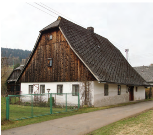
5. Dům čp. 35 tradičního objemu s prostorným podkrovím o více úrovních pod vysokou střešou. Originální roubení již nahradilo mladší cihelné zdivo, dispozice s komínem nad průchozí síní se zachovala. U vstupu je uplatněný oblíbený typ portálu s římsou na volutových konzolách, zde ojediněle v dřevěném provedení. K domu patří i dřevěná, šindelem pobitá kolna.
