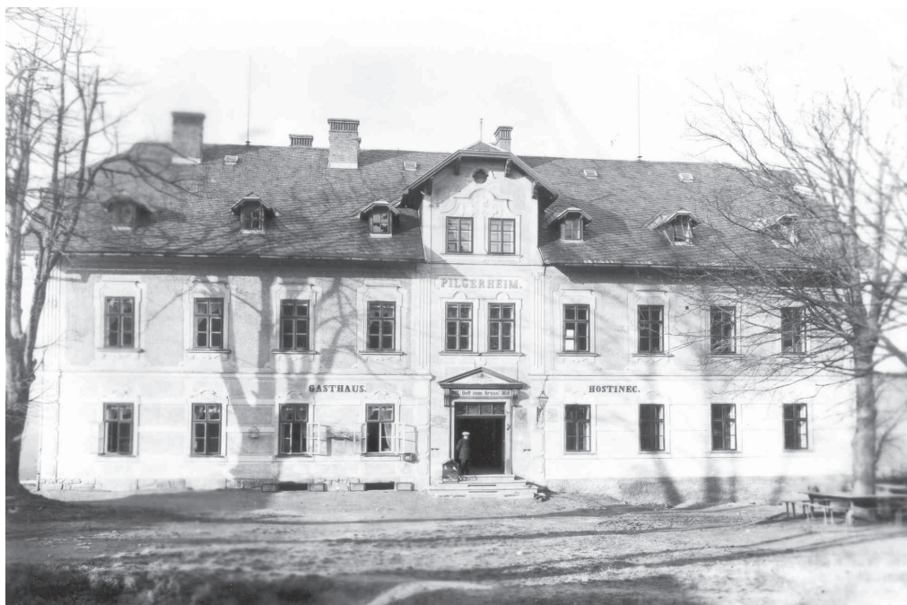
4-12 Dolní Hedeč, poutní dům čp. 2. Fotografie kolem roku 1925 zobrazuje podobu po přestavbě v roce 1902. Podélnému jednopatrovému průčelí proti klášteru, v němž se zachoval vstupní portál z roku 1850, dominuje náznakový střední rizalit, vystupující nad střechu v podobě dvouosé vikýřové nástavby. Vysoká okna hostince v neobarokních rámech vystupovala výrazně z hrubozrnné a barevně odlišené omítky. Hostinec měl ještě protáhlé boční křídlo, sestupující o něco níže ze svahu. (MM Králíky)
