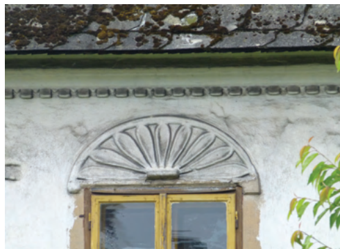
3-22 Červená Voda čp. 179, detail profilované korunní římsy s řadou kapek a suprafenestry v podobě půlkruhového vějíře.
