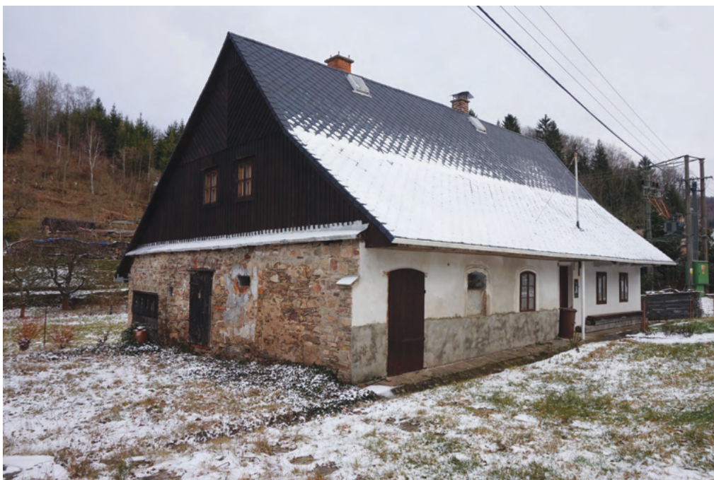
14. Domkářské stavení čp. 102, k roku 1839 v majetku Franze Dittricha, je jedním z mála roubených objektů, jehož hospodářská část byla přezděna již v mezidobí let 1839–1874. Tuto etapu reprezentují okna i dveře ve štukových šambránách se segmentovými záklenky. Obytná část byla přezděna později.
