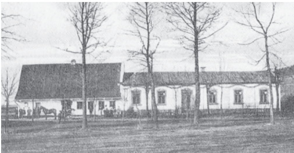
4-11 Dolní Orlice, hostinec Wunders s tanečním sálem zachytila fotografie z doby kolem roku 1900 jako přizemní křídlo, přistavěné k běžné roubené chalupě s nejjednodušší trojdílnou dispozicí. Oproti drobnému měřítku chalupy má hostinec téměř dvojnásobnou výšku místností a vysoká moderní okna. (OÚ Červená Voda)
