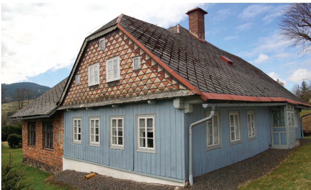
3-23 Lichkov, dům čp. 23 byl postavený po roce 1856 jako roubená novostavba již s nižším sklonem střechy bez tradičních námětků a s lichoběžníkovým štítem bez obvyklého předsazení. Dům je opatřen dobově běžnými výškově obdélnými okny. Prosklené secesní zádveří zakrývá dobře zachovaný dřevěný klasicistní portál s trojúhelným tympanonem.
