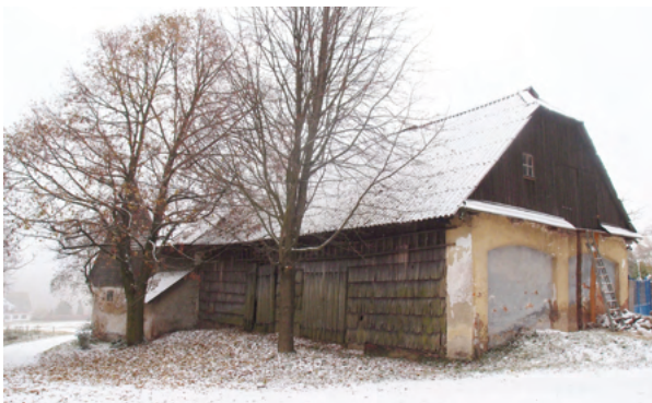
9. Hmota roubeného domu čp. 3 v Horních Boříkovicích prozrazuje tradiční jádro, k němuž patřila vysoká střecha prohnutého tvaru s mohutným komínem ve hřebeni a předsazený štít. Nynější asymetrie průčelí je vyvolaná úpravou krovu po rozšíření domu, již bez přetažení střechy pomocí námětků. K roku 1900 bylo v domě hlášeno 12 osob, převážně námezdních tkalců z větších továren v Červené Vodě a jejich děti.
