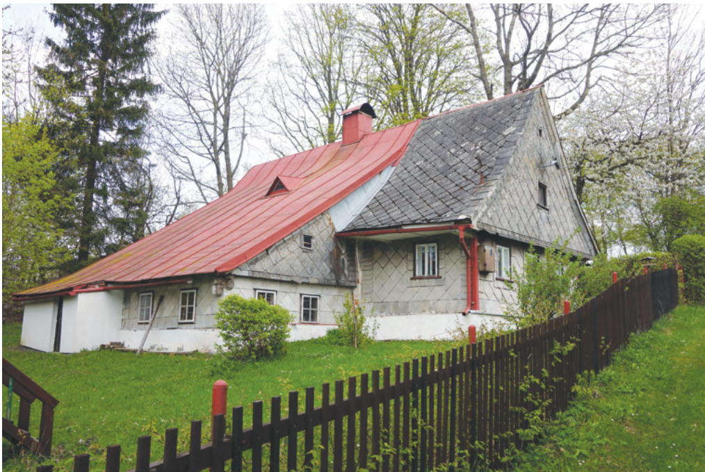
6. Chalupa čp. 98, jejíž roubené jádro se symetrickou sedlovou střechou z období přelomu 18. a 19. století bylo postupně podle osvědčených zvyků rozšiřováno tak, aby všechny části byly zahrnuté pod jednou střechou a v zimě přístupné „suchou nohou“. Sčítací operát k roku 1880 v domě uvádí 11 členů rodiny Katzerů, z nichž jedna dcera sloužila ve Vídni, druhá na statku v Prusku a starší syn byl ve vojenské službě, ostatní se zabývali tkalcovstvím, nádenictvím nebo zednictvím a prodejem v kramářské boudě u kláštera. (SL)
