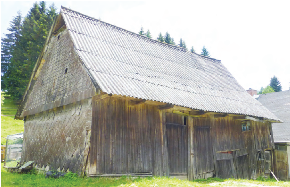
11. Horní Karlov, nedávno zbořená částečně roubená stodola usedlosti čp. 62, přistavěná kolem poloviny 19. století u starší chalupy. Provedení strmé sedlové střechy s valbičkou ve vrcholu a přesazeným bedněným štítem s trojicí větracích okének je ještě silně tradiční, patrová část měla zřejmě již typově mladší rámovou konstrukci s bedněním. Čelní stěnu chránilo šindelové pobití a později včetně štítu eternitové šablony.
