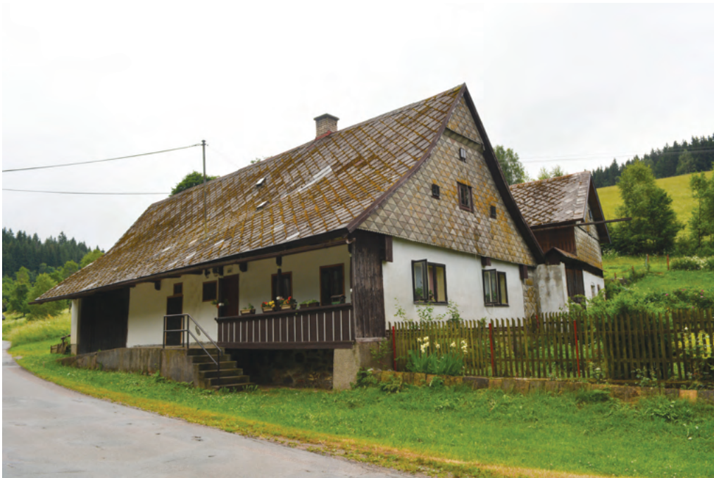
9. Zahradnická usedlost čp. 105 byla součástí okruhu prvního číslování v roce 1771. Roubená, částečně druhotně omítaná chalupa s typickou figurou střechy si zachovala pod nynější eternitovou krytinou starší šindel. Pod okny světnice je kvůli svahu doplněna dřevěná pavláčka. V podélné ose přímo navazuje dřevěná stodola a vozová kolna. Souběžně zděné chlévy dotvořily usedlost na počátku 20. století.
