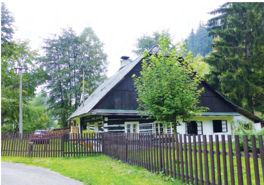
11. Rekreční chalupa č.e.2 (staré čp. 61) bývala kdysi roubeným domkářským objektem, doloženým nejpozději od roku 1815. Po polovině 19. století sloužila také jako obydlí textilních dělníků a ve 20. století jako kartáčnický obchod. Nynější široká hmota domu je výsledkem rozšiřování půdorysu a nastavování střechy. (Registr ČV)
