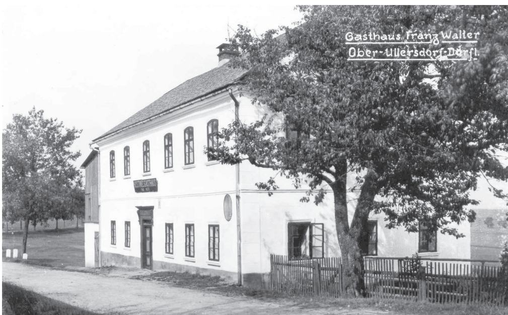
4-8 Horní Bořkovice, hostinec Walter čp. 11. V osamělé poloze při silnici u lesa stojí hostinec asi z 3. čtvrtiny 19. století v jednoduchém historizujícím stylu. Charakterizuje jej kompaktní podélný objem se sedlovou střechou, pravidelné fasády členěné římsami a na štítové straně navíc kvádrovanými lisenami. Šestitabulková okna na parapetních římsách mají zdobnělou historizující profilaci šambrán a v patře segmentové záklenky. Centrálním prvkem průčelí byl tmavě natřený portál králického typu. (MM Králíky)
