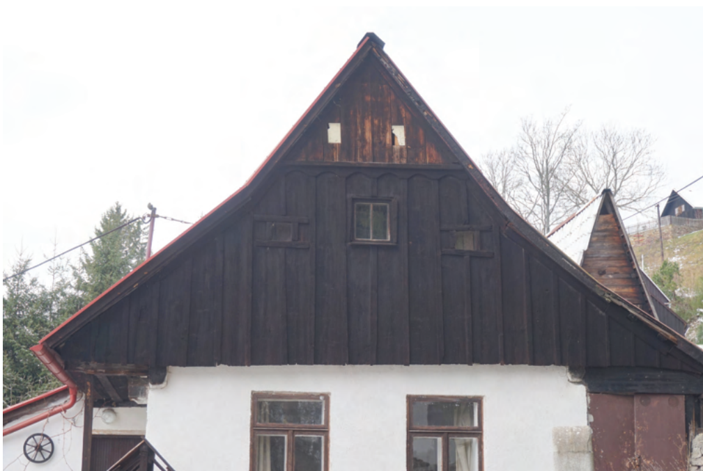
12. Nedávno zaniklá chalupa čp. 159 domkáře Franze Kröglera vznikla v rozmezí let 1785–1839. Byl zde zachován typický předsazený bedněný štít ze svisle kladených prken s lištovanými spárami, jehož vrcholová část je oddělená římsou podloženou obloučkově vykrajovaným prknem.
