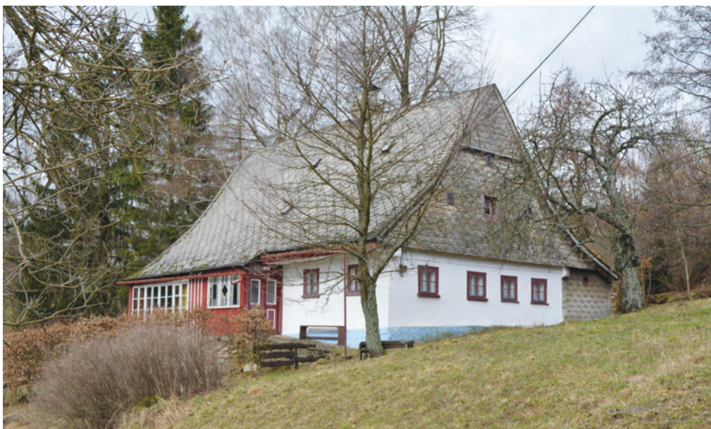
11. Chalupa čp. 43 zachycená k roku 1771 byla uvedena k roku 1839 jako obydlí domkáře Johanna Gablera a je představitelem tradičního typu z nejstarší zachované vrstvy domů ve vsi. Přízemní, plně roubený objekt s později omítanou světnicí má typický tvar střechy a předsazeného štítu, včetně místně tradiční trojúhelné sestavy okének s jedním větším uprostřed a trojicí drobných okolo. Malebným mladším doplňkem je prosklená vstupní veranda.
