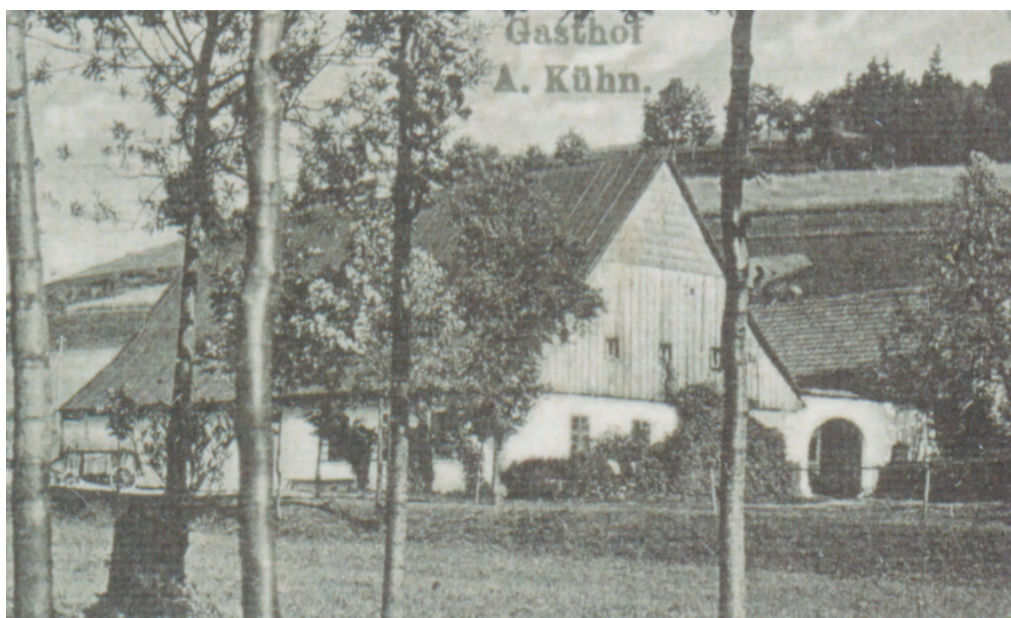
4. Bývalá erbovní rychta čp. 13, sloužící také jako hostinec (koncese doložena od roku 1881). Největší obytná stavba ve vsi, již před roku 1839 označena jako nespalná, s mohutnou střechou a bedněným štítem byla zapojena do menšího dvora, přístupného zděnou branou. Zanikla při přestavbě ve 20. století. (Archiv obce Červená Voda)
