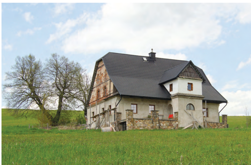
9. Historický pohled na samotu Tři Dvory, v pozadí selská usedlost čp. 83, s paralelní menší patrovou roubenou stodolou a vedlejším domkem pronajímaným hlavně textilním dělníkům. Zděný klasicistní objekt vznikl přestavbou statku doloženého v dnešní situaci od konce 18. století. Foto v průběhu stavební úpravy (po zboření stodoly). (OÚ Červená Voda, Registr ČV)
