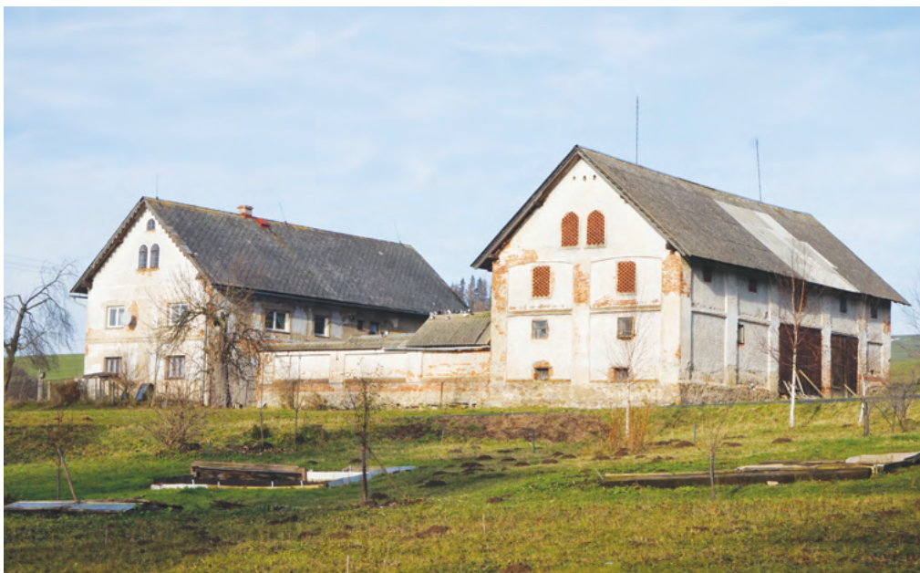
7. Největší selská usedlost čp. 52 byla přestavěná patrně v poslední čtvrtině 19. století v moderním stylu historismu. Zděná stodola, tvořící hmotový protějšek domu usedlosti, nahradila menší dřevěnou stavbu, která byla zachycena ještě k roku 1839. Spolu s úzkým zadním křídlem uzavřely dvůr do pravidelného tvaru. K roku 1880 zde žila Josefa Katzer s pěti dětmi a dvěma nádeníky v zemědělství s dalším dítětem. (SL)
