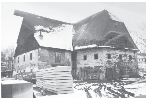
6. Bývalý mlýn čp. 2, zachycený urbářem k roku 1660, byl k roku 1835 vlastněn Filipem Gablerem a zbořen v devadesátých letech 20. století. Ojedinělý objekt s patrovým roubeným obytným dílem a vysokou zvalbenou střechou měl krov velmi úsporného provedení a šindelový štít. Byl zapojen v usedlosti s dřevěnými hospodářskými stavbami a vlastními polnostmi. V roce 1930 měl jedno kolo na svrchní vodu a fungoval navíc jako šindelka. (ČÚZK, www.vodnimlynny.cz , foto poskytl majitel)
