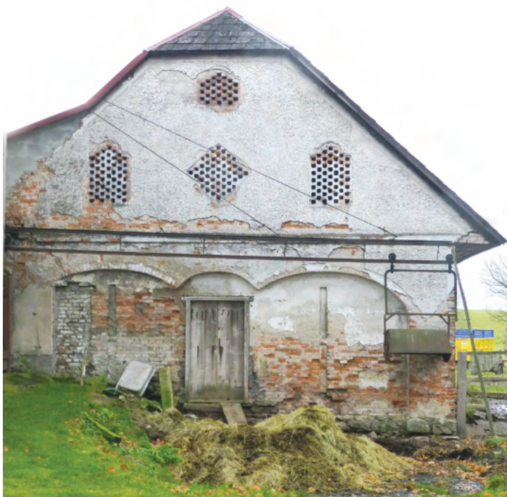
9. Zděná stodola usedlosti čp. 30 je ukázkou uplatnění pozdního historismu na hospodářské stavbě. Asymetrická slepá arkáda v přízemí zakomponovala i dvířka na hnojiště, štít zdobí cihelné větrací mřížky.
