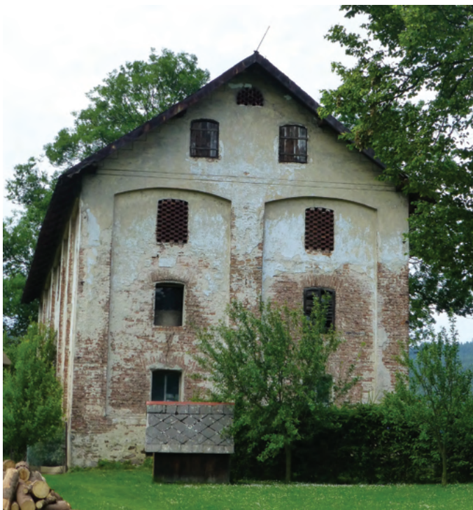
3-47 Červená Voda, usedlost čp. 180. Patrová hospodářská stavba charakteru skladiště, postavená v závěru 19. století, je řešena jako cihelná a hladce omítaná. Fasády člení lisenové rámy se segmentovými záklenky do vysokých polí, s osově umístěnými vysokými okny různého typu výplní. Štít se zbytky omítkového členění, zahrnujícího stupňovitý okraj a rýsovaný pás místo kordonové římsy, je doplněn dřevěným vyřezávaným okřídlim na okraji střechy.
