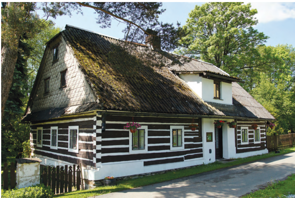
5. Jádro roubeného objektu čp. 39, zachyceného již na mapě stabilního katastru k roku 1839, má čela trámů rybinových spojů v nárožích kontrastně vyznačená bílou barvou. Dům prošel mladšími stavebními úpravami, jakými byla proměna tvaru střechy s podlomením nad přední štítovou stěnou a částečné přezdění stěn, včetně vikýře.
