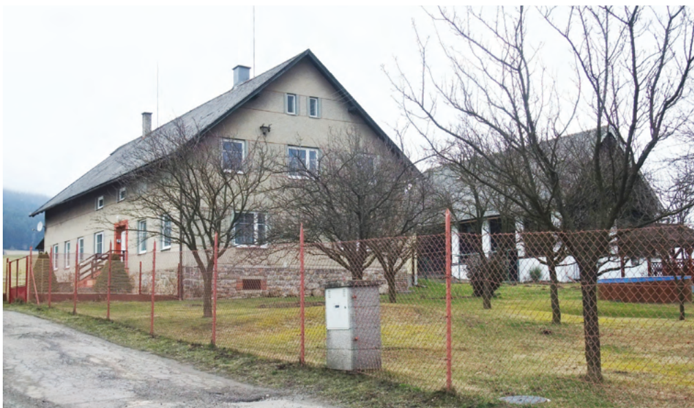
8. Dům zemědělské usedlosti čp. 7 existoval v nespalné podobě již k roku 1835 za Dominika Umlaufa. Součástí hospodářství byla paralelní dřevěná stodola, přestavěná nebo prodloužená před rokem 1897. Na mapě pozemkového katastru je zachycena prvorepubliková přestavba domu, čemuž odpovídá jeho zděná podoba s půdní nadezdívkou pod sedlovou střechou. Pozdější účelové úpravy poškodily architektonickou hodnotu. (Registr ČV)
