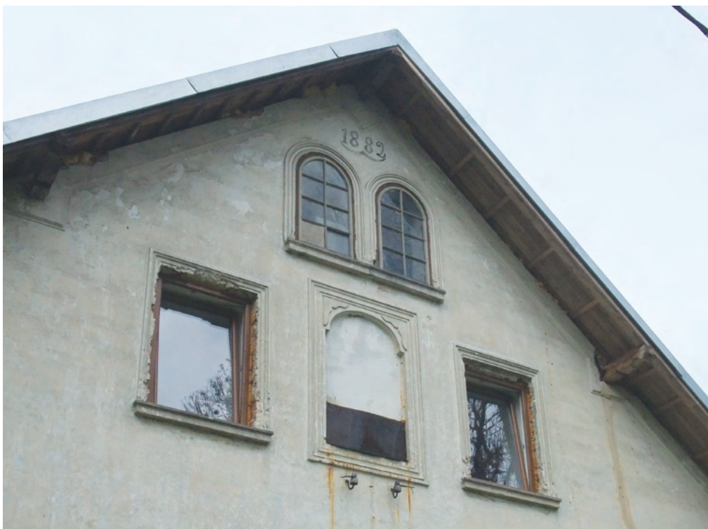
3-34 Dolní Morava čp. 12. Detail historizujícího průčelí s datací 1882, kdy byl dům postaven na nové parcele, již bez přímého vztahu k usedlosti. Uprostřed dominuje výrazně neogotický prvek okenní šambrány.
