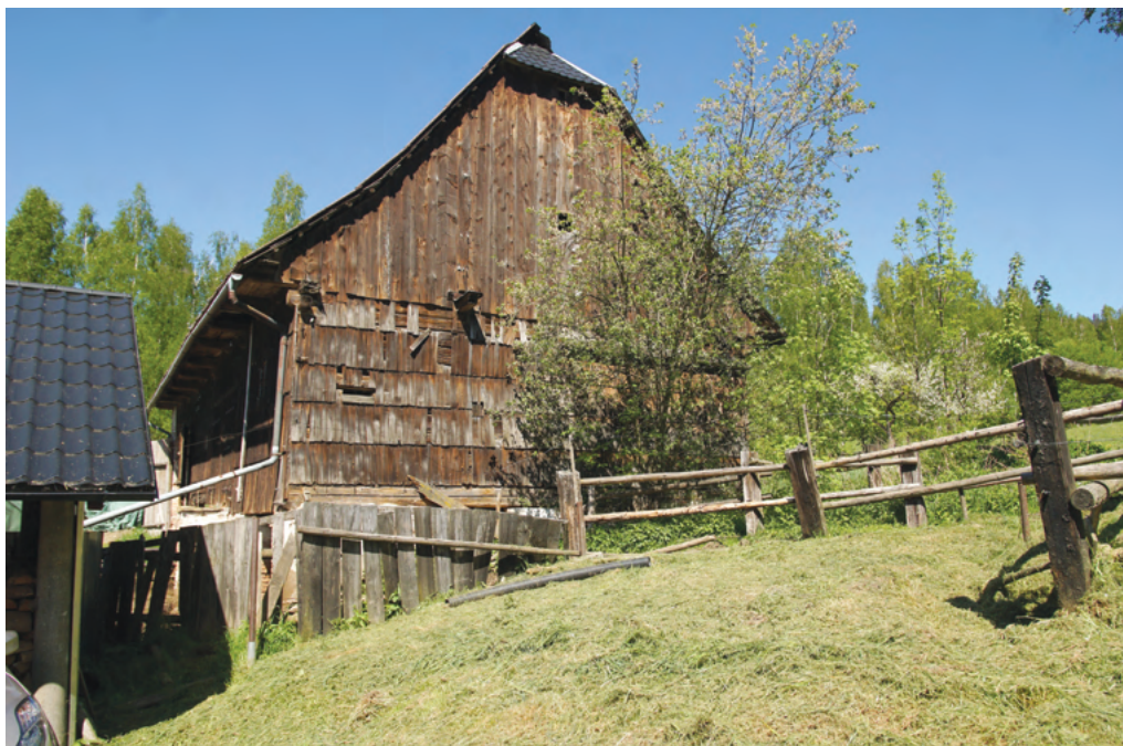
5. Tradiční selská usedlost čp. 52 s paralelní roubenou stodolou a klasicistním křížem z roku 1799 patří k památkově nejhodnotnějším stavbám ve vsi. Velká obdélná stodola se uplatňuje prkenným a šindelovým obkladem a zejména vysokou střechou s valbičkami nad bedněnými štíty. Majitel statku Dominik Dolležel je uváděn již k roku 1763, jeho rodině statek náležel ještě v roce 1869. Kříž podle pamětníků byl obklopen čtyřmi sokly, na nichž stáli andělé. Také zde sedláci v 2. polovině 19. století ubytovávali textilní a dřevařské dělníky. (Archiv Waldkraiburg, Registr ČV)
