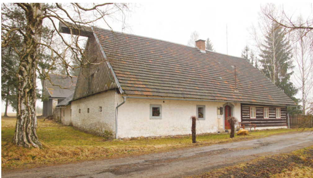
6. Zemědělská usedlost s čp. 22, uděleným k roku 1771, pochází v jádru z doby před rokem 1840. Dům smíšené konstrukce s paralelně stojící dřevěnou stodolou je dobrým příkladem tradiční regionální stavební typologie a stavebních detailů. Tvar a nasazení střechy bez námětků i podlomení štítu jsou dokladem mladších zásahů zachycených, podobně jako úprava stodoly, změnou zákresu na originální mapě stabilního katastru. K roku 1890 zde hospodařil sedlák, původem z Prostřední Lípky. (SL)
