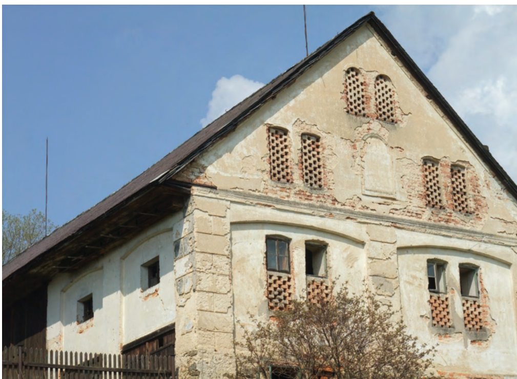
3-44 Dolní Morava čp. 38. Pohled na čelní štít stodoly, která byla postavena jako novostavba kolem roku 1873. Členění fasád plochými slepými arkádami a sdruženými okny odkazuje k historismu. Sedlová střecha je opatřena krovem hambalkové konstrukce.
