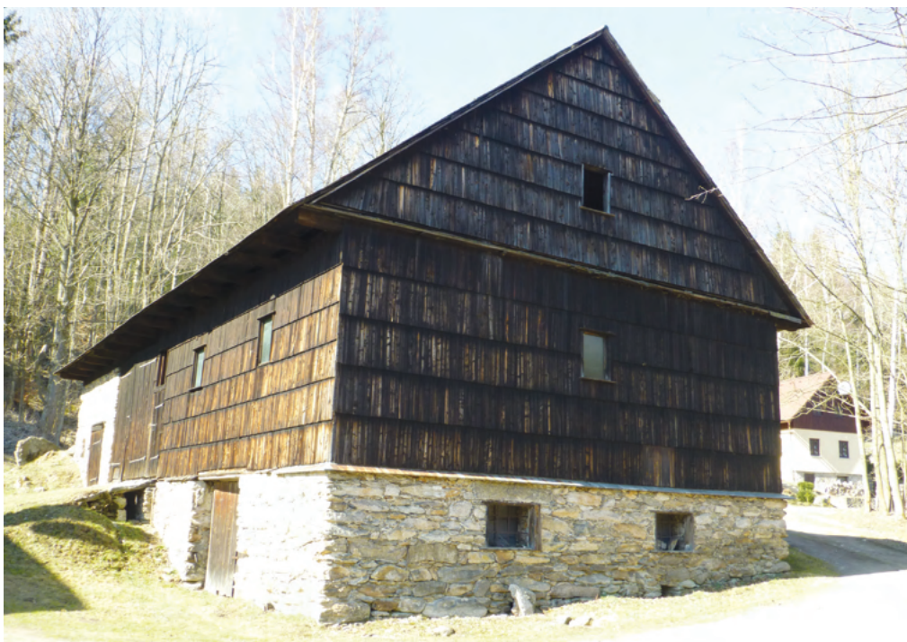
7. Stodola u čp. 29, která byla podle historických map postavena ve stávající hmotě až po roce 1898, má rámovou konstrukci pobitou šindelem a zadní část i vysokou podezdívku zděnou z lomového kamene. Také štít sedlové střechy využívá snadno dostupný tradiční šindel.
