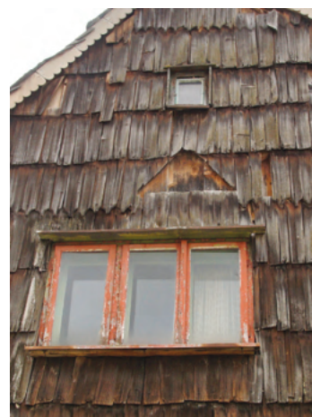
6. Dům čp. 85 je zástupcem nejstarší dochované vrstvy tradičních jednotných roubených domů ve vsi, číslo bylo přiděleno roku 1771. Asymetrická silueta vznikla postupným rozšířením. K typickým znakům patří bedněné štíty, obkládané později šindelem nebo eternitem. V detailu štítu je vidět trojúhelníková jizva po odstranění kukličky nad kdysi menším osově umístěným oknem. Dům postavený na bývalém rychtářském gruntu později sloužil jako obchod s přízí a domácká kartáčníká výroba. (Registr ČV)
