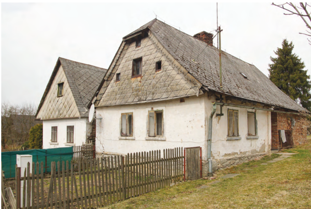
9. Šanov, zděné domkářské chalupy čp. 82 a 83 z 1. třetiny 19. století s tradičními střechami a eternitem pobitými štíty mají nejjednodušší trojdílnou dispozici, obsahující i malý chlév. Obývali je např. stužkař, cihlářští nebo textilní dělníci, domek čp. 82 sloužil také jako obecní pastouška. (Registr ČV)
