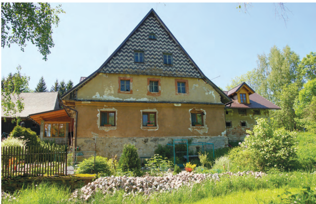
7. Selská usedlost čp. 25, náležející k prvnímu okruhu číslování z roku 1771, zapsaná v Josefském katastru s roubeným výměnkem čp. 26, který koncem 19. století zanikl. Dům s poměrně strmou střechou a předsazeným štítem, jehož krov a stropy vznikly podle dendrochronologické datace po roce 1822, je kolmo usazený do svahu, s vjezdem do podkrovní přímě z pole. K roku 1835 jej vlastnil Benedikt Brauner. (SL)
