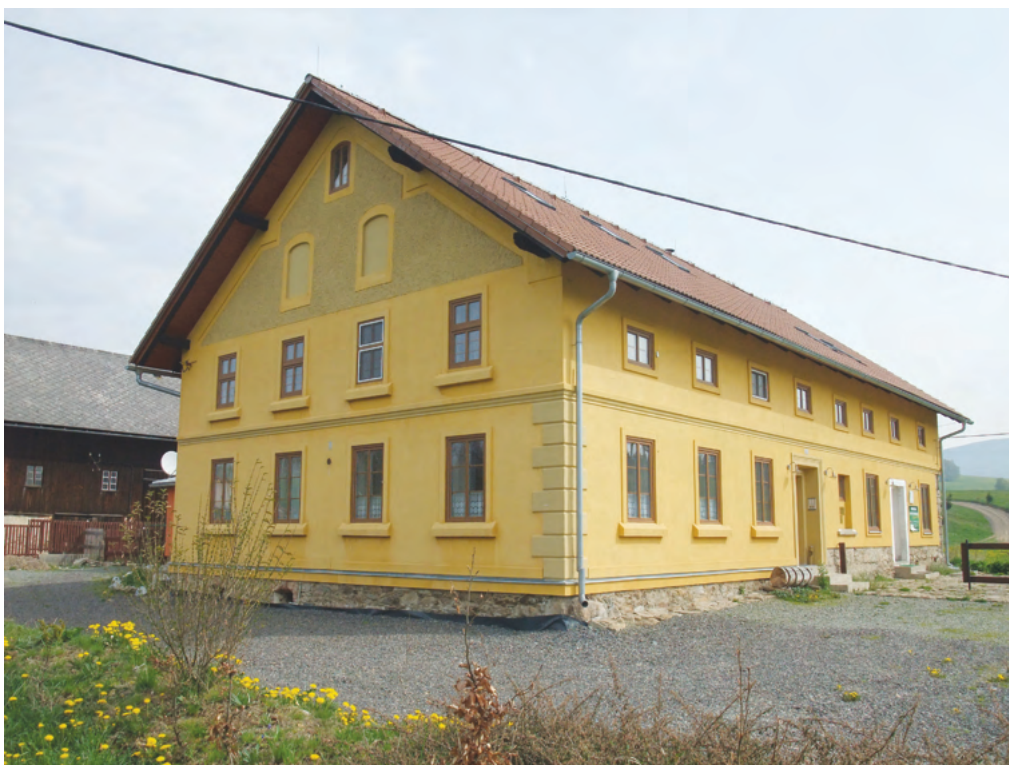
10. Dům usedlosti čp. 1 reprezentuje historizující vrstvu zdejších venkovských staveb z přelomu 19. a 20. století. Usedlost v trojstranné dispozici je složena z domu a paralelně situované stodoly a zděného spojovacího zadního křídla. Dům se stodolou se obrací svými štíty do údolí řeky Moravy.
