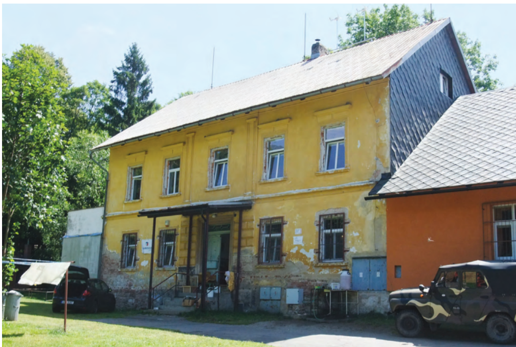
10. Budova školy čp. 72 byla postavena ve stylu historismu až roku 1866. Její předchůdce, zobrazený na mapě stabilního katastru k roku 1839 jako menší spalný objekt, sloužil také jako škola. V současnosti se využívá jako zázemí letního chatového tábora.
