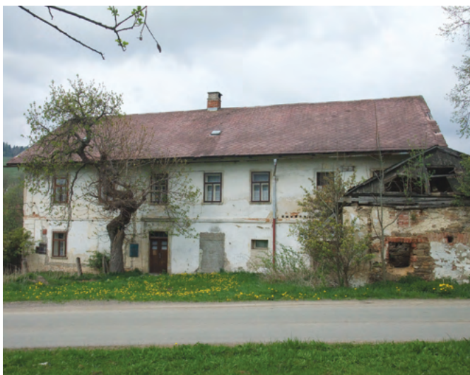
11. Nedávno zbořená usedlost čp. 20, pocházející podle vročení na portálu z roku 1871, měla jednoduchou kompaktní patrovou hmotu, v okolí často užívanou a historizující detaily členění (římky, kamenné parapety, profilované okenní šambrány, rustikované a pilastrové nároží). Dvůr dotvářela cihelná stodola s typickými dekorativními cihelnými mřížkami a plochým obloučkovým vlysem.
