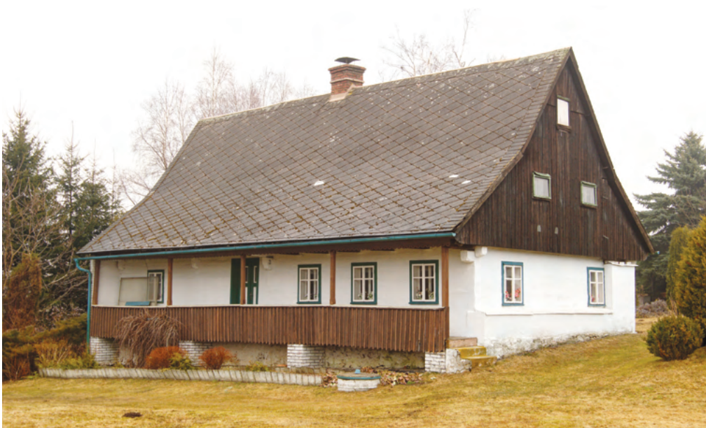
3. Obecní chalupa s popisným číslem 3 (doloženým k roku 1771) stála ještě v roce 1840 přímo podél staré silnice, jejíž úvoz je v terénu ještě částečně čitelný. Roubený objekt s oboustranně obytnou dispozicí, obýval v roce 1890 námezdný tkadlec. Větší formát oken, krytina i přezdění zadní stěny prozrazují pozdější modernizace. (SL)
