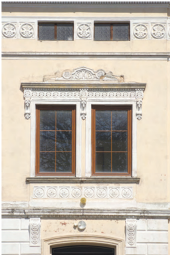
11. Příklady užití dekorativních reliéfních prvků na fasádách z období historismu, často připravovaných jako dílenský prefabrikát a montovaných dodatečně na stavbu. Reprezentativní úprava zahrnovala i interiérové haly se sloupy a mřížovým zábradlím nebo náročně vyřezávané dveře.
