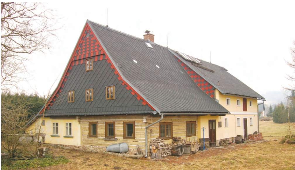
5. Ze starší celodřevěné usedlosti čp. 85 (popisné číslo přiděleno k roku 1771) s volně situovanou stodolou se zachoval částečně přezděný dům s tradiční vysokou střechou a dřevěným štítem. Ke staršímu jádru patří minimálně světnice roubená z tesaných trámů, krov s dlouhými námětky a předsazený štít. Majitelem k roku 1890 byl sedlák Prause, narozený v Dolní Lipce, za něhož nejspíš došlo k modernizaci a navýšení hospodářského dílu o polopatřo s typickou seníkovou kladkou ve štítu. (SL)
