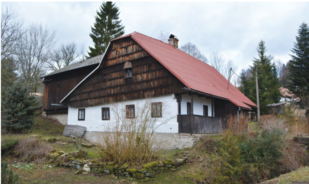
10. Autentická chalupa čp. 32, jejíž jádro může pocházet z 18. století (roubená světnice). Podle soupisu SK z roku 1839 byl uveden majitelem objektu domkář Alois Hrdina. V 2. polovině 19. století byl objekt rozšířen o další trakty přistavěné k západní podélné straně domu. Stodola využívá terénní situace k napojení na podkroví domu a přímý vjezd ze svahu.
