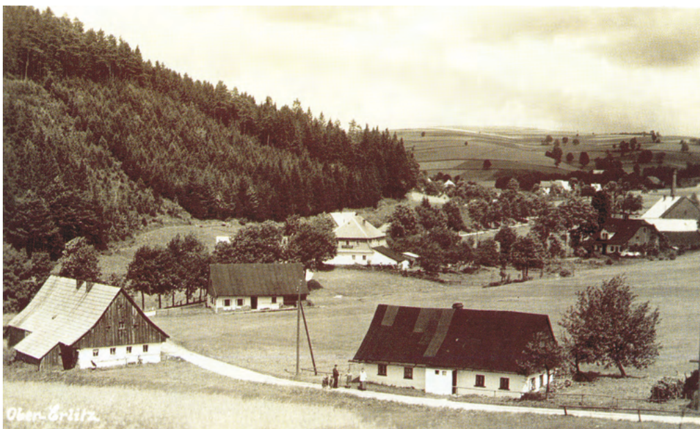
3. Historická fotografie z 1. poloviny 20. století. (Archiv obce Červená Voda)
