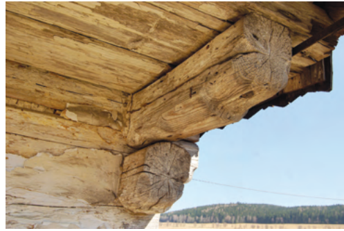
5. Drobný roubený dům čp. 68, uváděný k roku 1787 jako výměnek k čp. 69, který patřil rodině Höppe ještě v roce 1869. Objekt s jednoduchou trojdielnou oboustranně obytnou dispozicí zachovává řadu tradičních znaků, jako rybinové spoje roubení, tesařské zdobení přesahujících horních trámů, tvar a symetrické nasazení střechy, i malá okna téměř čtvercového formátu. (Registr ČV)
