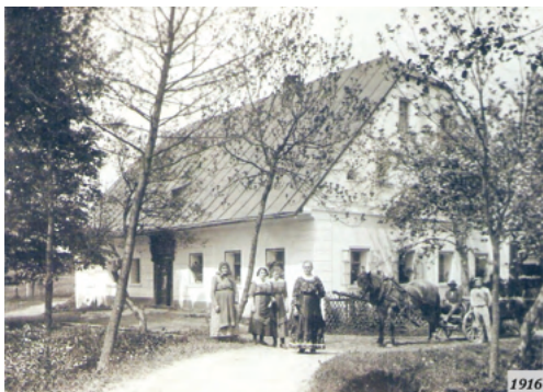
3-21 Králíky, zaniklý klasicistní dům s oblíbenými prvky štukové výzdoby, tvořené omítkovým rizalitem kolem vstupního portálu, kvádřovaným nárožím, profilovanou korunní římsou a štukovými šambránami oken s kamennými parapety. Okna jsou dvojité, dvoukřídlá o šesti tabulkách, vnější křídla se otevírají ven. (MM Králíky)
