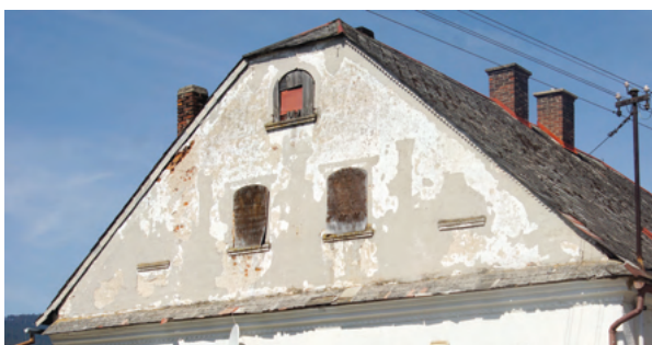
8. Motivy vějířů nebo stopy pilastrového členění štítů, které byly oblíbeným prvkem klasicistních zděných staveb, se zachovaly jen ojediněle (zde na čp. 179 a čp. 194).
