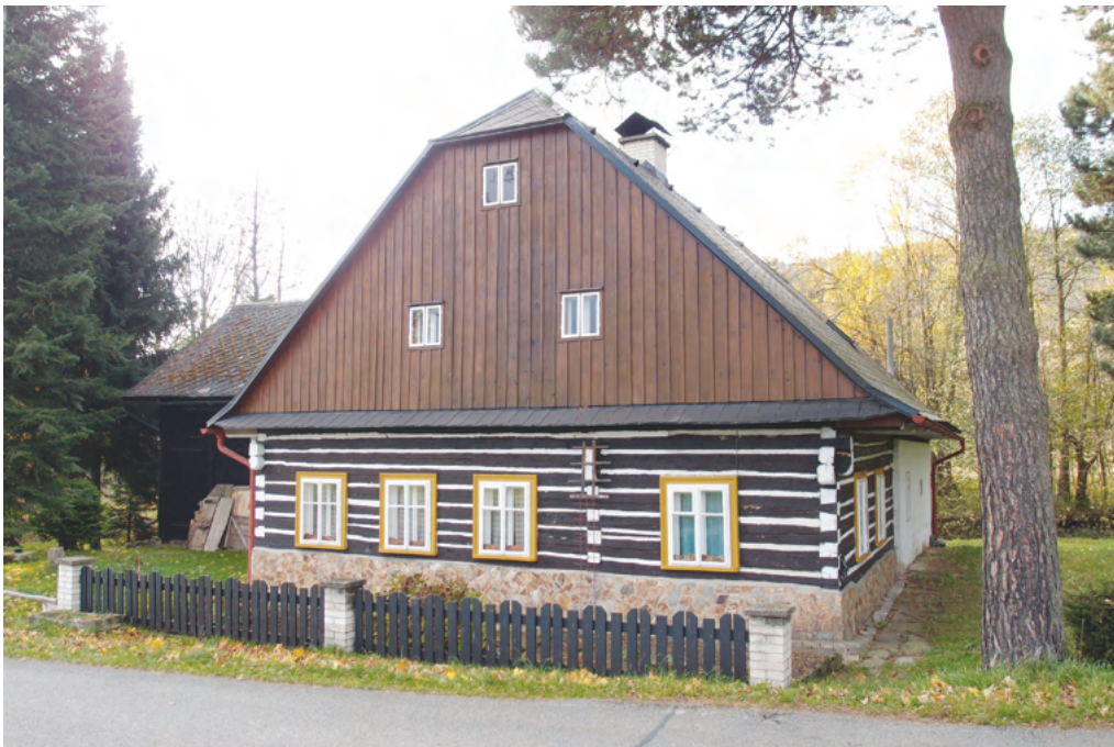
6. Řemeslnická chalupa čp. 15 byla postavena na obecním pozemku mimo starou sídelní strukturu, na místě svého předchůdce až poměrně pozdě po polovině 19. století, což dokládají nejen mapové operáty, ale také tvar střechy a velikost oken. Tradice uspořádání staveb dvora v hákové sestavě ovlivnila i novostavbu, ačkoli již s oddělenou stodolou. Domek k roku 1880 obýval tkalcovský pomocník. (SL)
