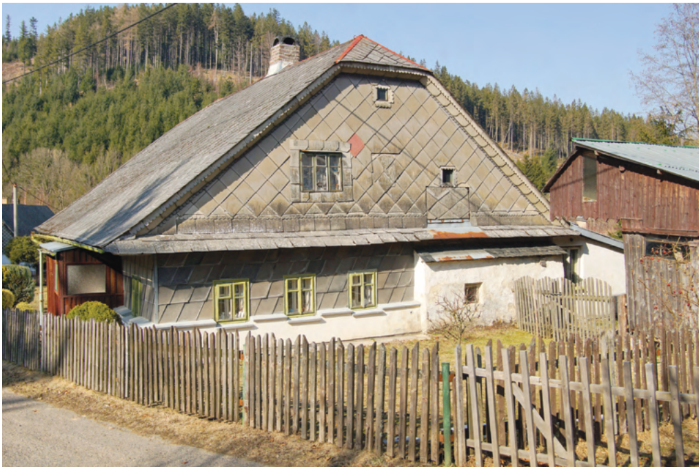
8. Dům čp. 20 s roubeným jádrem z doby před rokem 1839, rozšířený o zděný zadní trakt někdy před rokem 1898. V průběhu 19. a na počátku 20. století zde bydleli často domácí tkalci. Eternit chrání před nepřízní počasí dřevěné části stavby.
