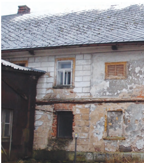
3-18 Dolní Boříkovice čp. 126. Dům usedlosti z roku 1863 představuje progresivní ukázkou patrového zděného domu z období nastupujícího architektonického historismu. Objekt je na dvorní straně před chlévy vybavený arkádovým náspím a na přední straně síně datovaným vstupním pískovcovým portálem králického typu. Fasáda má na podélné straně dosud čitelné štukové členění římsami a soklem, v přední části doplněné kvádřovou rustikou a okna vybavená profilovanými šambránami s pískovcovými parapetními římsami.
