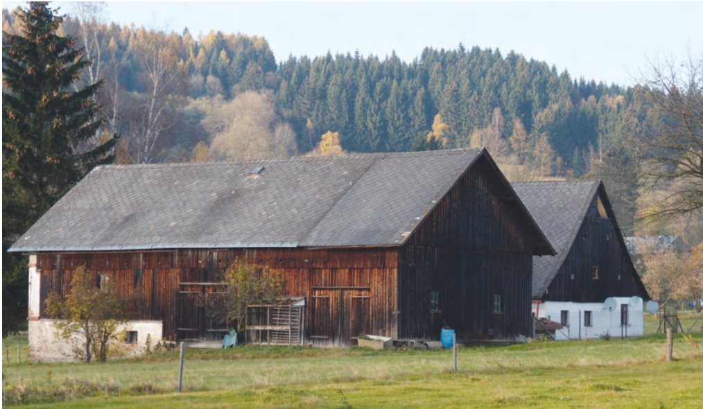
5. Usedlost čp. 24, nedaleko kostela, je součástí staré sídelní struktury vsi. Podle záznamu z katastrálních map přeživala hluboko přes polovinu 19. století v dřevěné podobě. Kdysi delší jednotný dřevěný dům s dvoutraktovou dispozicí doplňovala menší samostatná stodola. Do zděné podoby pod zachovanou střechou byl dům přestavěný asi v poslední čtvrtině 19. století, kdy jej doplnila velká paralelní bedněná stodola. Majitelem hospodářství byl k roku 1880 Franz Kubelka. (SL)
