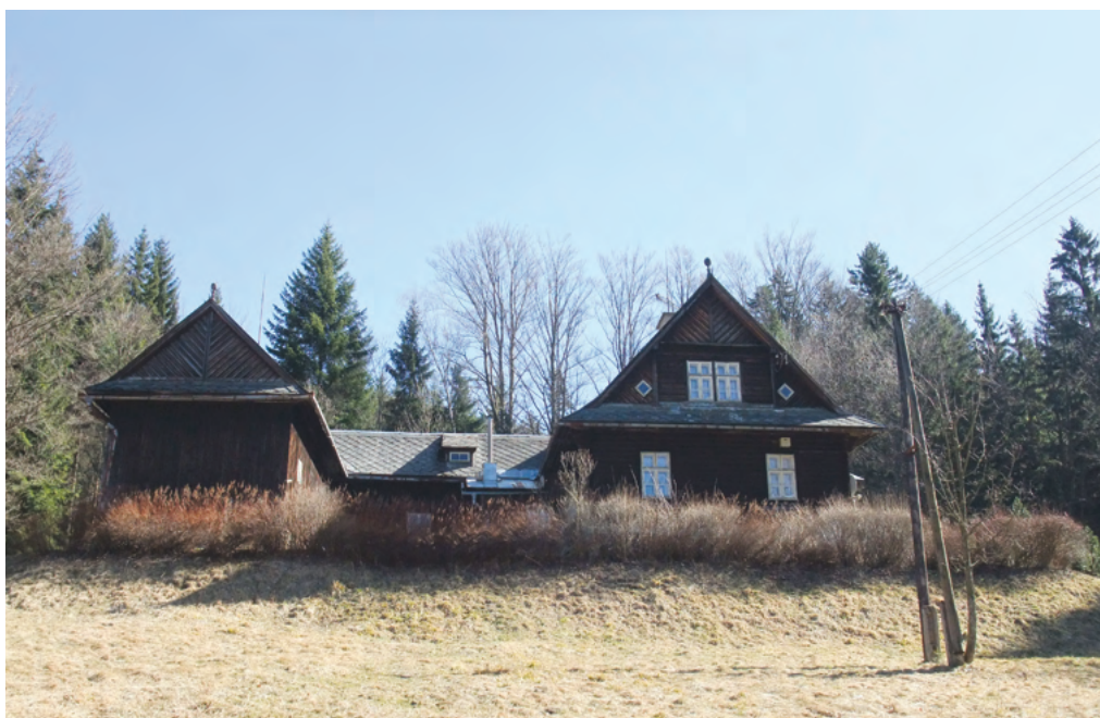
12. Lesovna čp. 92 je příkladem architektonické tvorby 1. třetiny 20. století, na pomezí secese a moderny. Napodobuje menší usedlost, zasazenou do terénu na okraji lesa.
