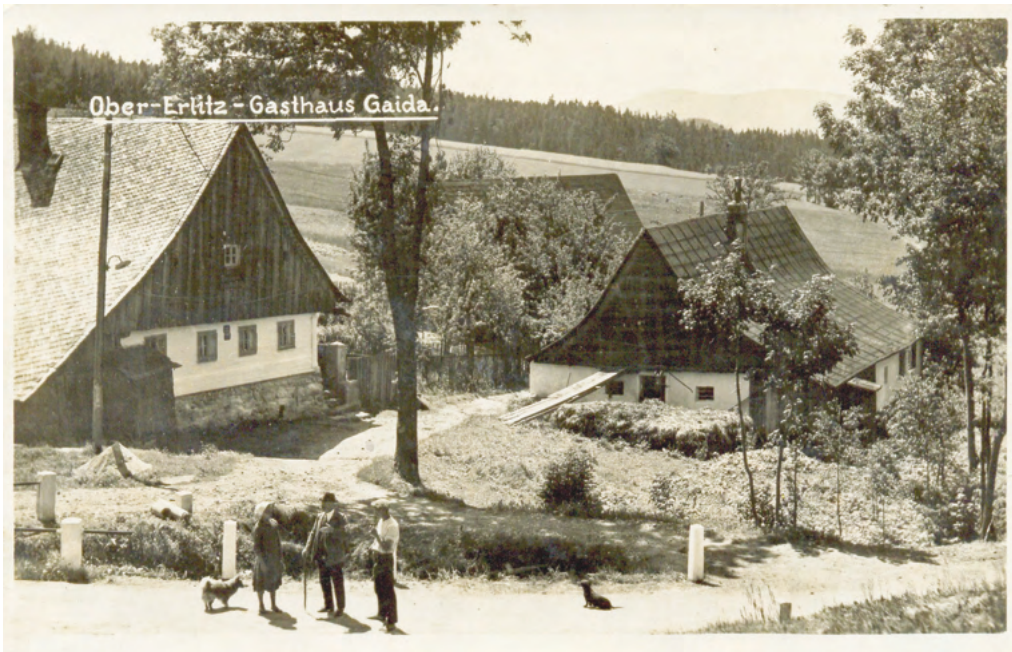
4-3a,b Horní Orlice čp. 32. Zaniklý hostinec Gaida byl roubenou stavbu typické tradiční siluety, opakující obvyklou trojdílnou dispozici s dlouhou průchozí síní uprostřed, avšak ve třetím díle ve vicetraktovém provedení (s pokojem, prodejnou a špúnou). Přední část tvořil velký čtvercový prostor hostinského sálu. (MM Králíky, SOKA Ústí nad Orlicí)
