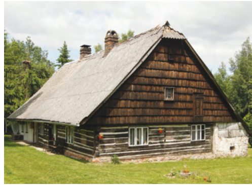
8. Roubená domkářská chalupa čp. 40 v Dolních Boříkovicích, s oboustranně obytnou dispozicí, pojala pod prodloužené křídlo své mladší střechy i zděnou hospodářskou přístavbu, která je zachycena na mapě po polovině 19. století. Opodál stojí socha sv. Anny, postavená nákladem majitele Wenzela Kühna v roce 1866. K roku 1880 zde žili manželé Wagnerovi, námezdní tkalci s rodinou a služebnou. (SL)
