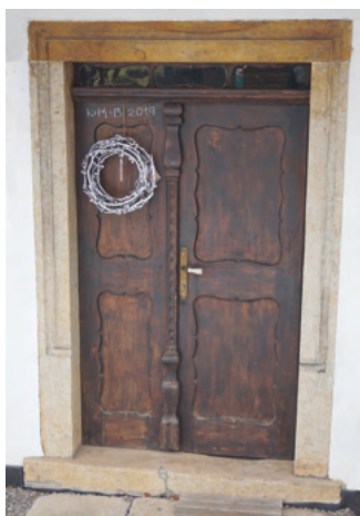
15. Dveře do zděného domu čp. 3 domkáře Aloise Schlesingera z 2. poloviny 19. století. Vstup je rámován profilovaným pískovcovým ostěním. Dveře pozdně barokního typu jsou dvoukřídlé s nestejně širokými křídly rámové konstrukce s nadsvětlikem z ručně vyráběného skla a mají profilovanou sloupkovou klapačku.
