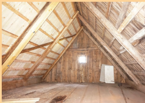
3-7 Pohled do horní části podkroví zachytil původní svislé bednění štítu, laťování pro šindelovou krytinu, zavětrování střechy šikmou latí i dřevěnou podlahu s bočními prkny nad hambalky, sloužící k uskladnění sypkých plodin.
