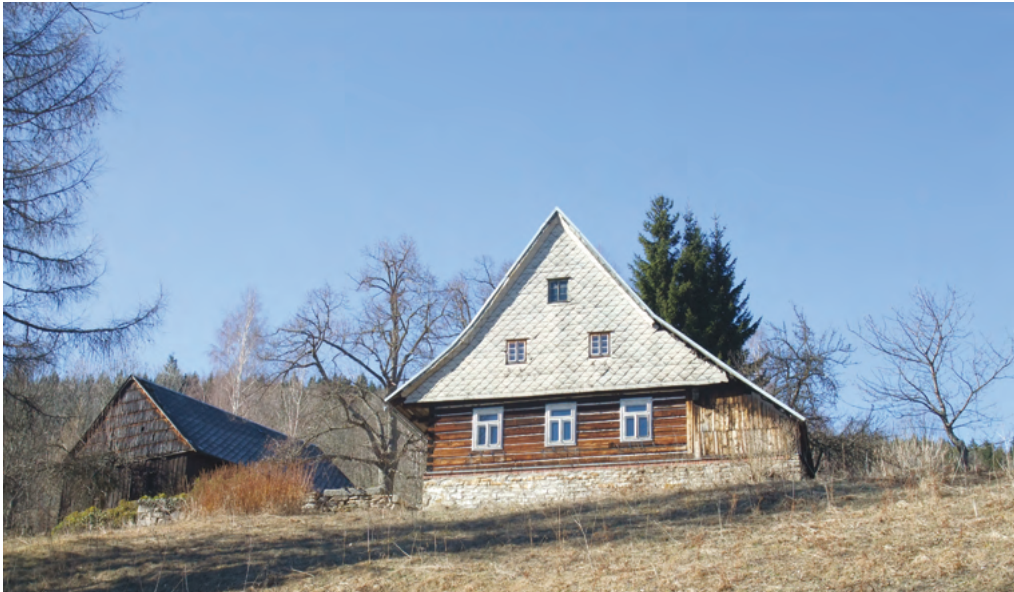
4. Zahradnická usedlost čp. 14 reprezentuje tradiční podobu zástavby Horní Moravy ve strmém údolí, s navazujícím krátkým lánem pod zalesněným vrchem. Usazení do terénu, štítová orientace roubeného domu, předsazený štít i poloha mladší dřevěné stodoly patří k typickým znakům zdejších staveb. Ještě k roku 1900 se majitel zabýval zemědělstvím. (SL)
