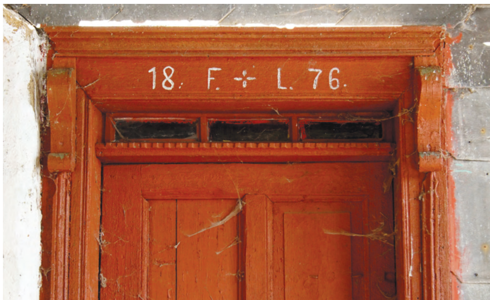
7. Autenticky dochovaná chalupa čp. 137 v horní části vesnice, v lokalitě, kde po druhé světové válce zanikla většina objektů. Dům s tradiční typologií a roubenou světnicí, který sloužil i jako hostinec, byl postaven podle vrocení na dřevěném portálku až roku 1876. Tomu odpovídá i jednoduchý tvar střechy a skladba oken v šindelovém štítu. K roku 1880 vedl hospodářství Franz Jäckel, bývalý vrchní dozorce finanční stráže, s mladým synem a truhlářským učněm. Historická fotografie s obíleným roubením dokládá i tradiční údržbu vápennými nátěry, které ve 20. století nahradil eternitový obklad. Portálek oblíbeného typu v dřevěném provedení je datován do roku 1876. (SL)
