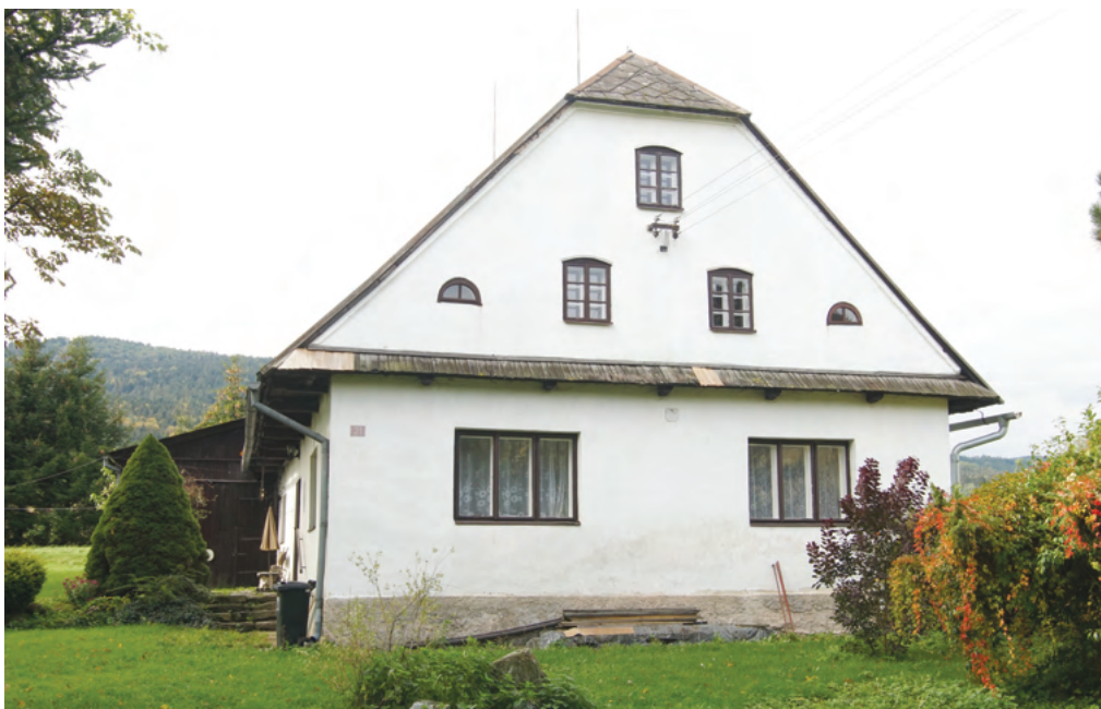
10. Předchůdce domu čp. 21 byl zachycen již v roce 1771 prvním okruhem číslování, před rokem 1798 se uvádí koupě domu od vrchnosti. Zděný klasicistní domek na nevelkém hospodářství byl postavený roku 1841 Franzem Langerem na místě staršího objektu. Dům má kromě typické hmoty zachovaný i štít s půlkruhovými okénky po stranách. (Registr ČV)
