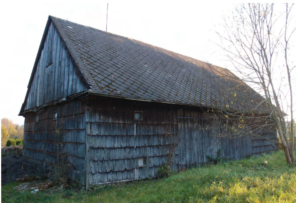
3-41 Horní Lipka čp. 77. Obdélná stodola rámové konstrukce s šindelovým obložením byla postavená až v poslední třetině 19. století.
