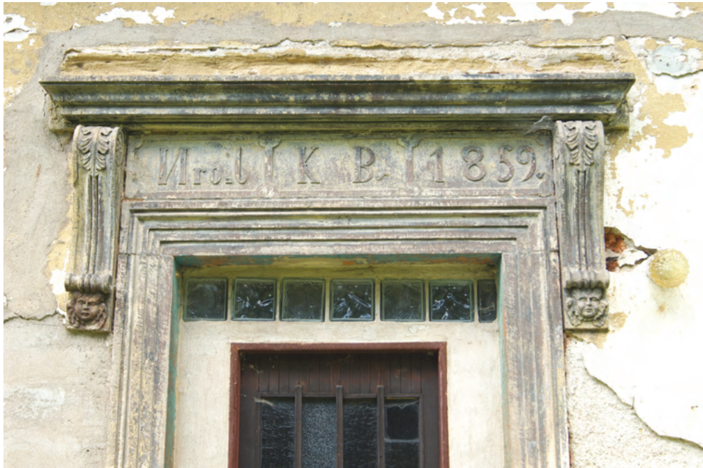
9. Portál oblíbeného typu z roku 1859 byl součástí přízemního klasicistního domu čp. 6 s arkádovým náspím a zděným štítem. Dům se zachoval v upravené podobě po nástavbě půdního polopatra. Řemeslně kvalitní provedení portálu podle klasického vzoru nekoresponduje s nejistým provedením nápisu, který zřejmě doplnil nepřiliš gramotný řemeslník.
