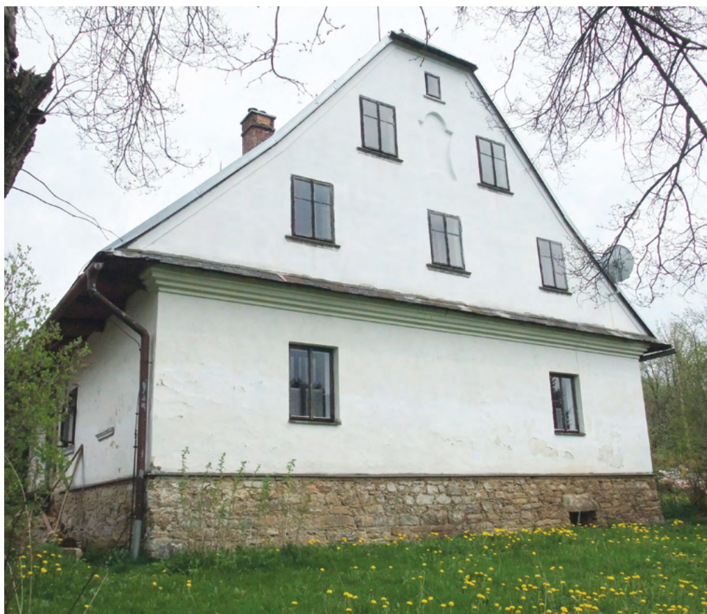
7. Dům čp. 19 byl postavený jako novostavba v padesátých letech 19. století vedle staršího dřevěného předchůdce v usedlosti. Má stále klasicistní hmotu se zděným štítem, který zdobí mělký kasulový výklenek. Štuková klasicistní výbava fasád se nezachovala, zůstaly pouze kamenné parapety a zděná profilace římsy vynášející štít. Na místě zrušeného vstupu do síně se zachoval portál s trojúhelným tympanonem.
