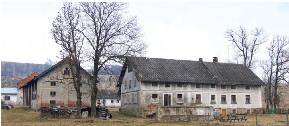
3-38 Prostřední Lipka čp. 64 je ukázkou velké selské usedlosti, která ještě ve třetí čtvrtině 19. století byla kromě domu převážně dřevěná a do nynější podoby byla přestavěna až na začátku 20. století, jak připomíná vročení 1904 ve štítu stodoly, s iniciálami P. N. Moderní vaznicový krov umožnil využití půdního polopatra, které obsluhovala kládka ve štítu. Prosperující usedlost byla upravovaná ještě v roce 1929 a zachovala se v poměrně autentické podobě.
